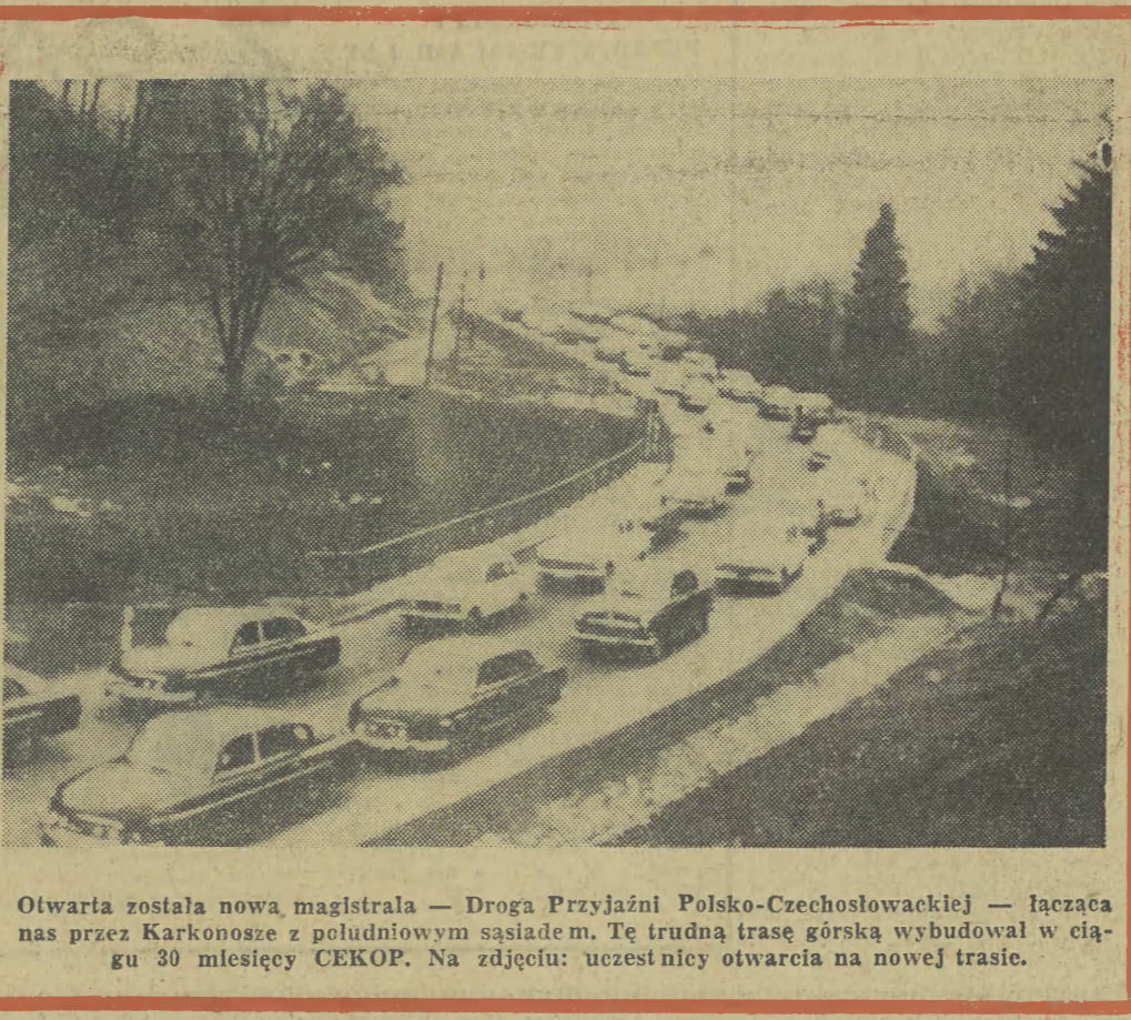
Otwarta została nowa magistrala — Droga Przyjaźni Polsko-Czechosłowackiej — łącząca nas przez Karkonosze z południowym sąsiadem. Tę trudną trasę górską wybudował w ciągu 30 miesięcy CEKOP. Na zdjęciu: uczestnicy otwarcia na nowej trasie.
