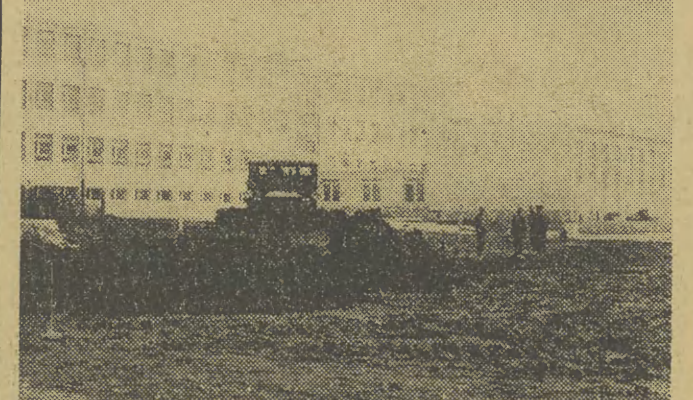
Nowa szkoła na Krowodrzy przy ul. Litewskiej. W miejscu przysięgi boiska pracuje jeszcze spychacz. Fot. W. Klag
