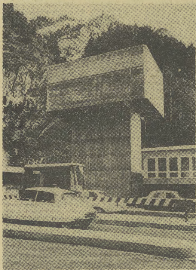
Dziwna konstrukcja w wylotu tunelu pod Mont Blanc nie jest super nowoczesną rzeźbą. Jest to szyb wentylacyjny stanowiący część urządzenia dostarczającego do wnętrza tunelu świeże powietrze. Wydajność urządzenia wentylacyjnego 800 m powietrza w ciągu sekundy.
