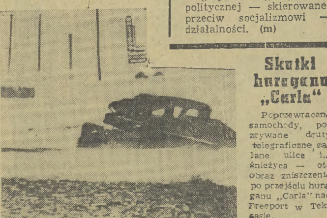
Skutki burzy „Carla” Poprawiacz samochodu, pozostawiony w miejscu, zrywane druty telegraficzne, zalane ulice i... śnieżyca — oto obraz zniszczenia po przejściu huraganu „Carla” nad Freeport w Teksasie. Fot. CAF
