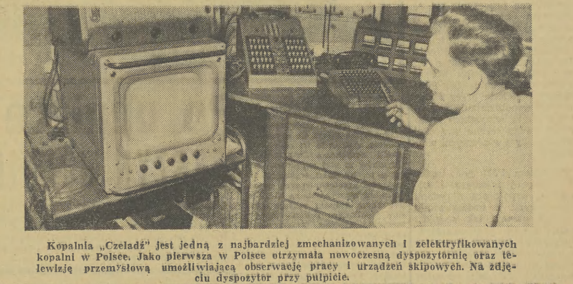
Kopalnia „Czeladź” jest jedną z najbardziej zmechanizowanych i zelektryfikowanych kopalni w Polsce. Jako pierwsza w Polsce otrzymała nowoczesny dyspozytor oraz telewizję przemysłową umożliwiającą obserwację pracy i urządzeń skopowych. Na zdjęciu dyspozytor przy pulpicie.
