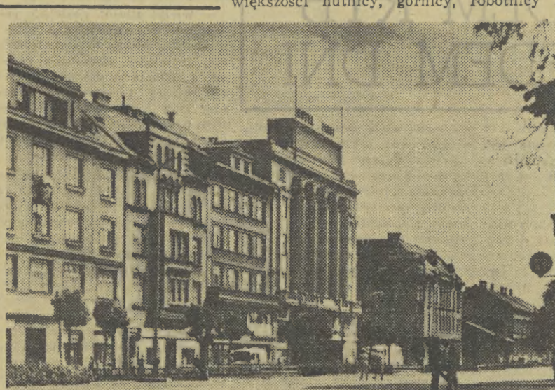
CZEŚKI CIESZYŃSKA ULICA K. GOTTWALDA Najwyższy budynek to hotel „Piast”, w którym mieszczą siębiurowa Zarz. GL PZKO i redakcji miesięcznika „Zwrot”. Obok (po prawej) siedziba Tesinskiego Divadla.
