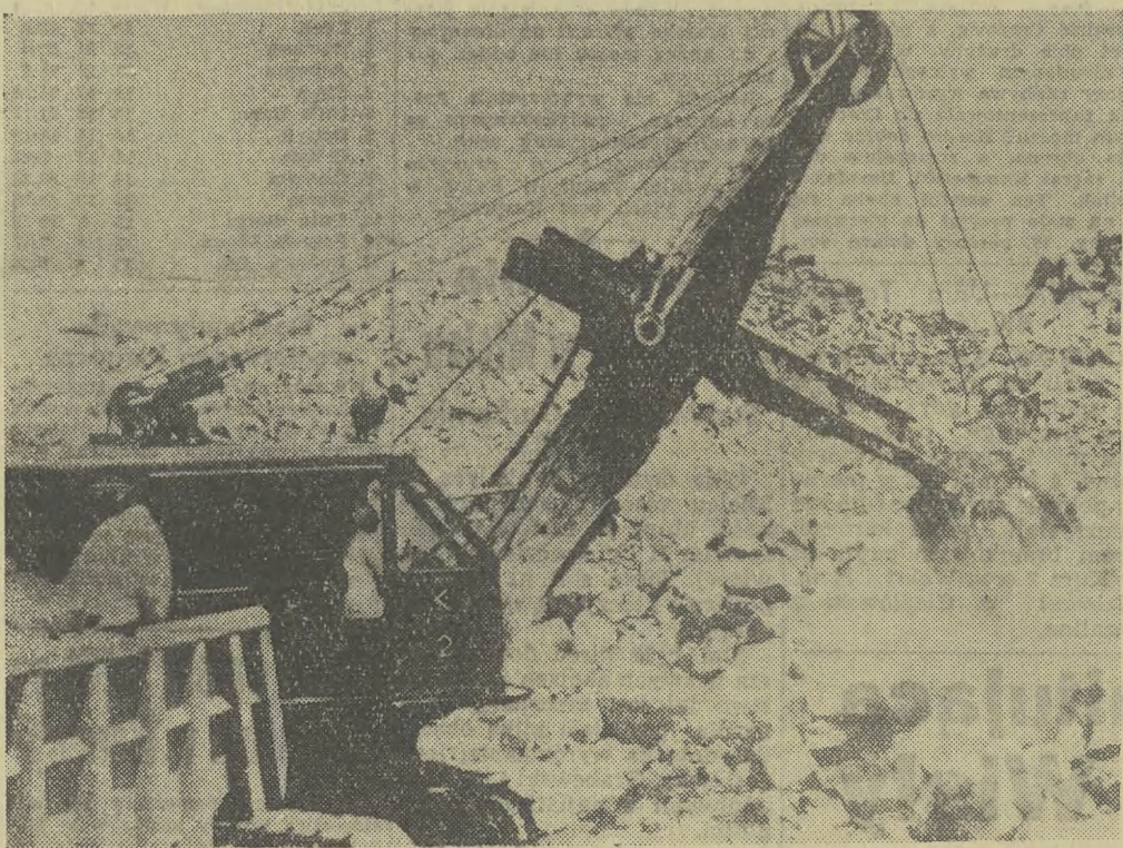
Ze świata. Na zdjęciu: Radziecka koparka na budowie tamy assuańskiej w ZRA. FOT — CAF
