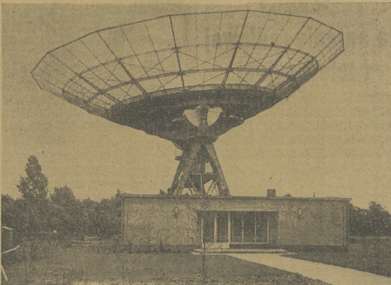
W ramach prac Międzynarodowego Roku Geofizycznego oddano ostatnio do użytku w Instytucie Heinricha Hertza Niemieckiej Akademii Nauk w Berlinie-Adlershof drugi co do wielkości w Europie radioteleskop. Lustro radioteleskopu posiada średnicę 36 m. Fot. — CAF
