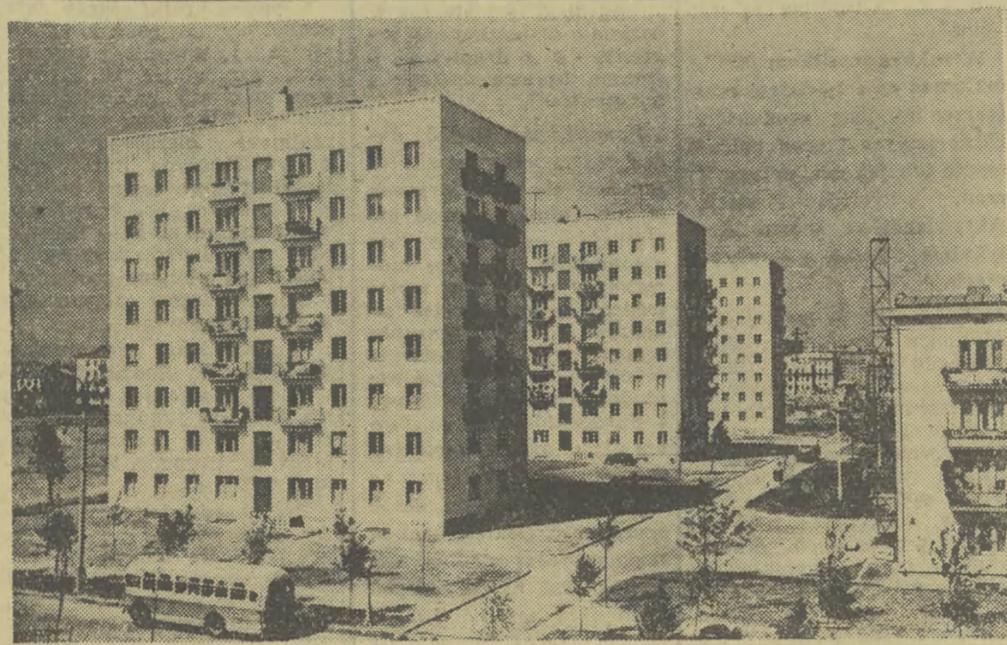
Zakończono w tym roku budowę i oddano do użytku nowe osiedle mieszkaniowe, noszące nazwę: „Dzielnica Nr 9”. Dzielnica ta, 2-krotnej domy posiadają dwa i trzy-pokojowe mieszkanie, jest przeznaczona dla 1900 rodzin. W czasie trwania ostatniego Międzynarodowego Kongresu Architektów, „Dzielnica Nr 9” zwróciła liczne delagacje zagraniczne. Na zdjęciu: Domy „Dzielnicy Nr 9” budowane są z żużlo-betonowych elementów prefabrykowanych. Fot. CAF
