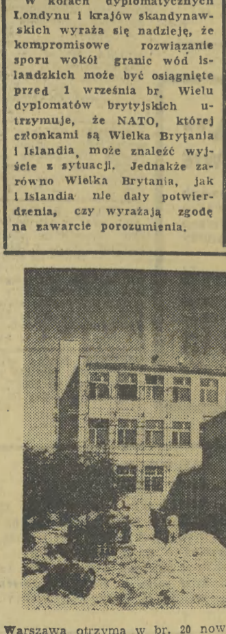
Warszawa otrzymała w br. 20 nowych gmachów szkolnych. Na zdjęciu: budowa szkoły przy ul. Kawęczńskiej na Pradze.
