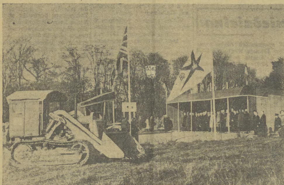
Przed Międzynarodową Wystawą 1958 r. w Brukseli. — Na zdjęciu: Rozpoczęcie prac na terenach wystawowych, na których zostanie wzniesiony pawilon Wielkiej Brytanii. Fot. — CAF
