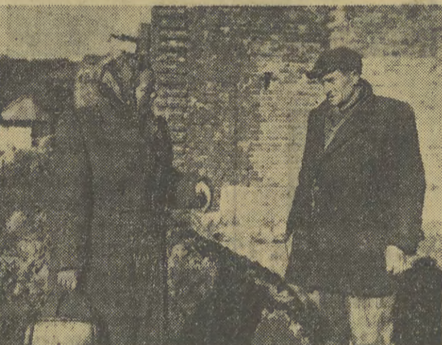
Nie ma dnia, by na budowie zabrakło przewodniczącej Prezydium GRN w Tegoborzu — M. POŁOMSKIEJ. Podczas nieobecności kierownika budowy o stanie robót najlepiej informuje brigadzysta — Stefan ZASADNY.
