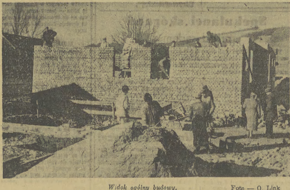
Widok ogólny budowy.
