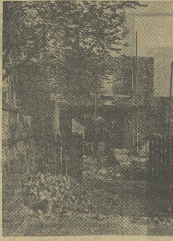
Niezależnie od pracy roku — trwają prace konserwatorskie i rekonstrukcyjne na Wawelu. Na zdjęciu: fragment prowadzonych obecnie robót. fot. A. Piotrowski
