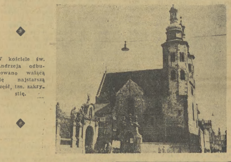
W kościele św. Andrzeja odbudowano walcącą się najstarszą część, tzn. zakrytą stłą.
