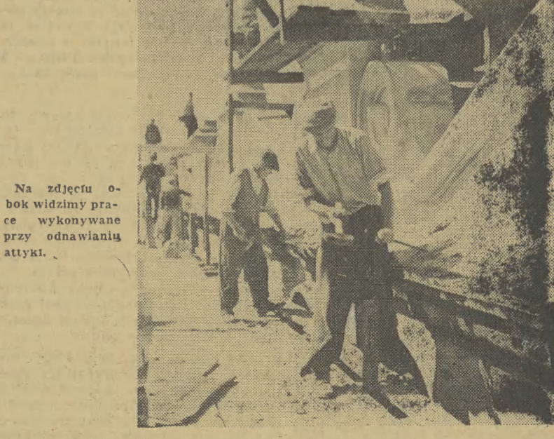
Na zdjęciu o-bok widoczny prac wykonywane przy odnawianiu attyki.
