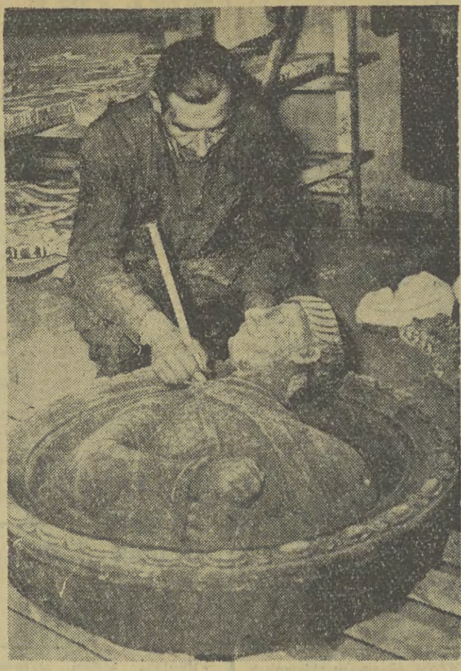
W zakładzie ceramicznym spółdzielni CPLA „Plastyk” w Kadynach, artyści-plastyki Wybrzeża wykonują detale architektoniczne z ceramiki czerwonej, przeznaczane na fasady kamieniczek staromiejskich w Gdańsku. — Na zdjęciu: artysta-plastyk Franciszek Lutek pracuje nad medalionem przeznaczonym na fasadę kamieniczki przy ul. Długi Targ nr 4. CAF — fot. Kosycarz
