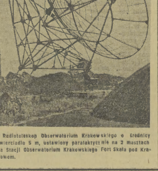
Radioteleskop Obserwatorium Krakowskiego o średnicy zwierciadła 5 m, ustawiony paraliaktycznie na 2 masztach na Stacji Obserwatorium Krakowskiego Fort Skala pod Krakowem.
