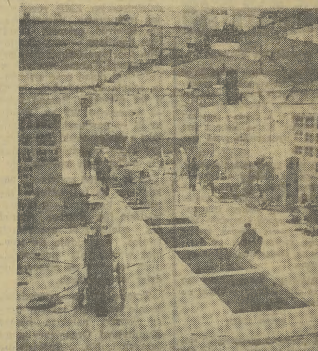
W Andrychowskich Zakładach Przemysłu Bawełnianego powstaje wysoko wydajna i całkowicie automatyzowana farbiarnia bawełny, której uruchomienie już w krótkim czasie nie tylko uniezależni zakład w tym zakresie, ale pozwoli również na farbowanie bawełny innym zakładom. Na zdjęciu: fragment farbiarni w czasie wykonywania prac montażowych kotłów do farbowania.
