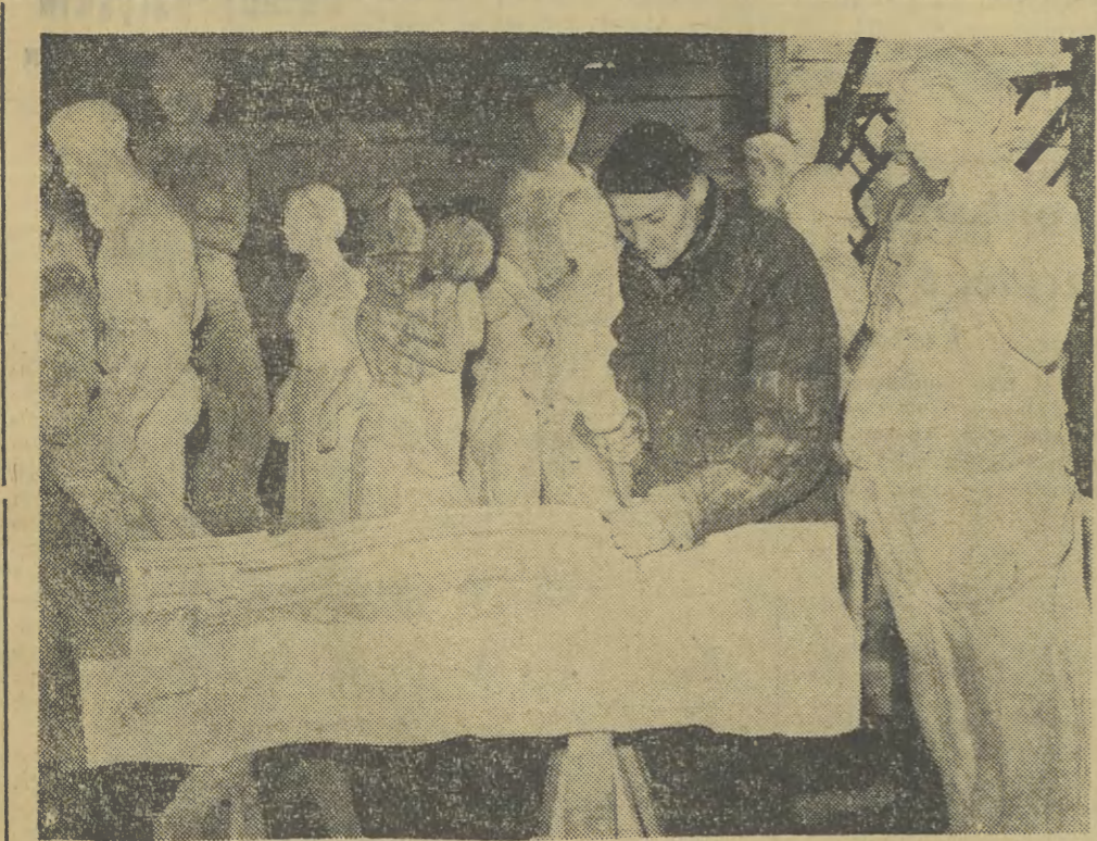
Pracownia kamieniarsko-rzeźbiarska ZBM Gdańsk — Elewacje, wykonana już wiele rzeźb i detali architektonicznych, które zdobią fasady kamieniczek, przy ul. Długiej, Ogarnej, Długi, Tary, Piłkarskiej i innych. Na zdjęciu: artysta-kamieniarz L. Baranowski wykluwa w kamieniu tzn. kartusz czyli środkową część portalu przeznaczoną dla kamieniczki nr 37 przy Długim Tar-gu. W głębi — rzeźby przeznaczone dla Zielonej Bramy. CAF — fot. Kosycarz
