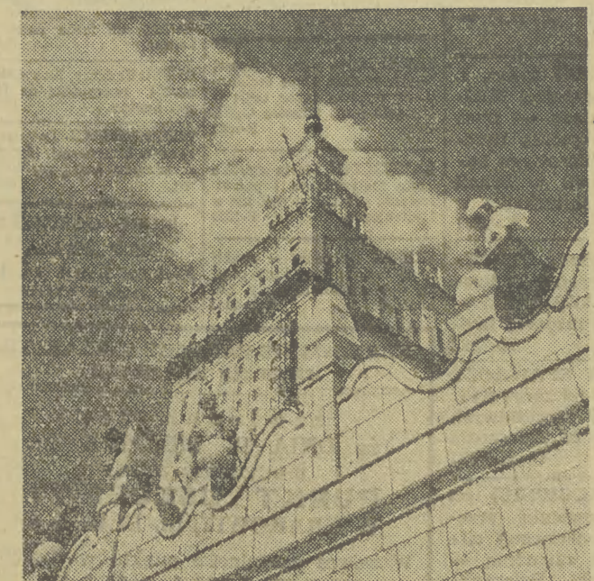
Prace wykończeniowe przy skrzydłach bocznych Pałacu.
