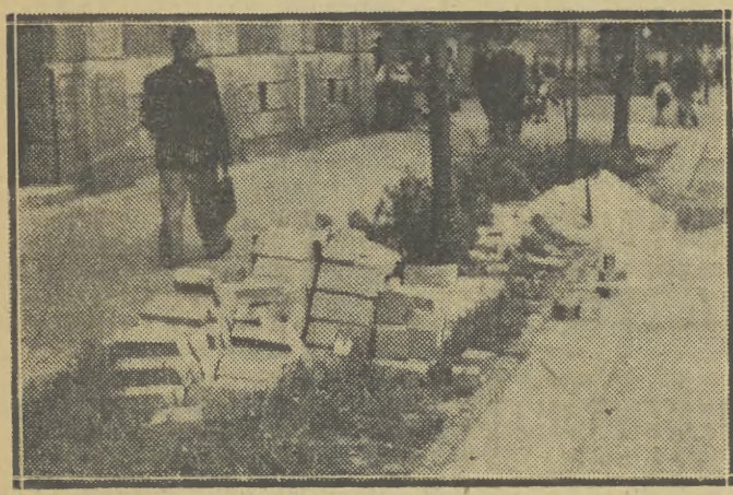
Prace przy budowie nowego obiektu przy ul. Inwalidów 7/8.
