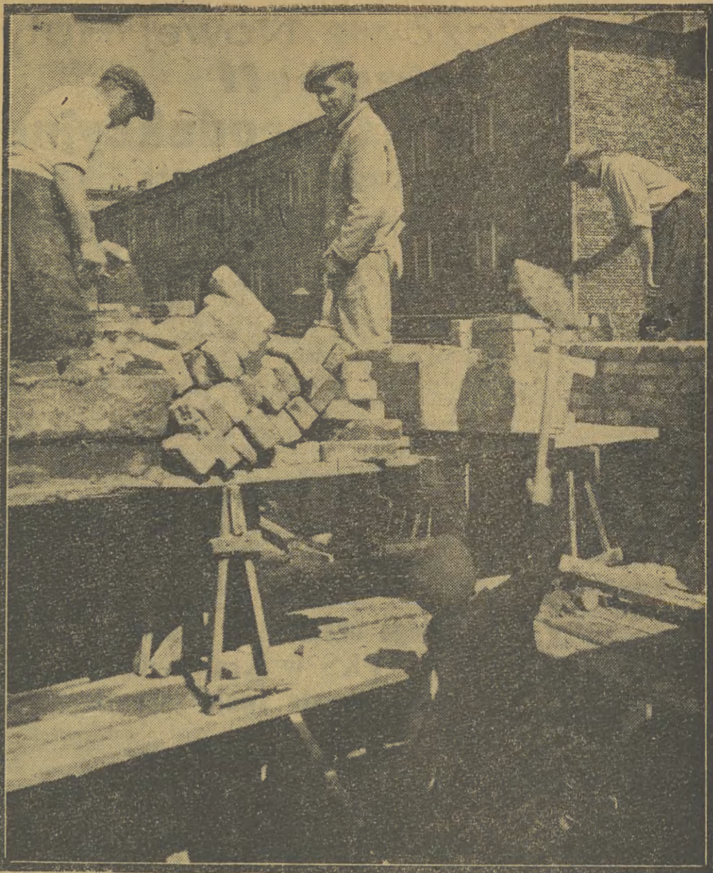
Przy budowie osiedla mieszkaniowego Ochota zastosowano metodę inżyniera radzieckiego Kowalowa. Metoda ta eliminuje wszelkie zbędne ruchy, wprowadza lepszą organizację pracy i pozwala osiągnąć przy mniejszym wysiłku większe wyniki pracy. Brygady murarskie pracujące przy budowie osiedla podniosły swoją wydajność o 20 procent. Na zdjęciu: brygada murarska Stanisława Pietrzaka, pracująca metodą Kowalowa w składzie: Wacław Kuleza, Stanisław Pietrzak, Tadeusz Swaczynski i Szepean Smolinski, wyrabia średnio 225 proc. normy. CAF — fot. Nowosielski
