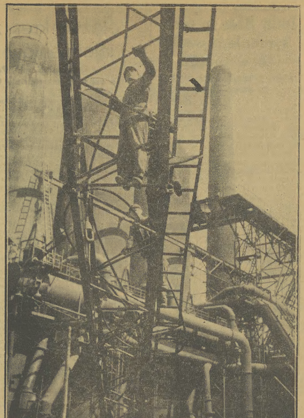
W roku ubiegłym został oddany do użytku wielki piec „B” w hucie „Kościusko”. Natychmiast go uruchomieniu przystąpiono do budowy wielkiego pieca „C”...
