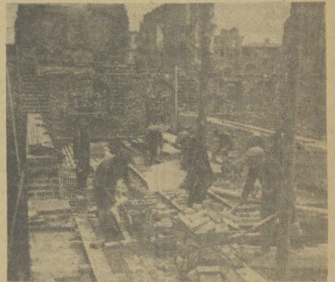
Murarze na Starym Mieście podejmują zobowiązania 1. Maja. Murarze grupy Kornackiego i Walczaka zobowiązali się na dzień 1 maja br. oddać w stanie surowym 2 kamienice przy ul. Piwniej 21 i 23. Na zdjęciu: grupa przy zakładaniu stróp piwnicznych
