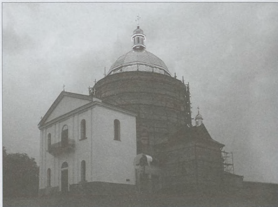
Fot. 2. Hoszów, cerkiew (1834-1842), w trakcie renowacji (fot. Łukasz Quirini-Popławski, 2008 r.)
