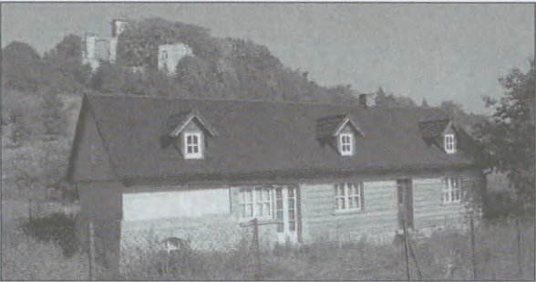
Zdjęcie 11. Chałupa wiejska po renowacji (sentymalny powrót do archetypu lokalnego) (stan aktualny).
