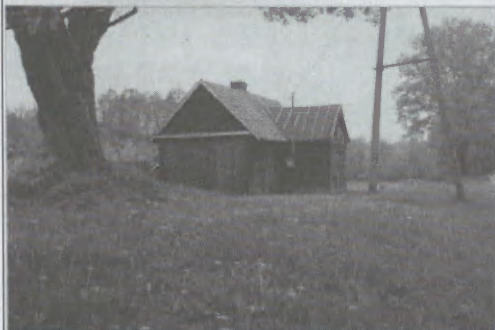
Belno Nr 48. Chałupa drewniana, lata 40-te XX w. wł. Widok od strony półn.-zach. (Fot. M. Holewiński. 12.05.2003 r.)
