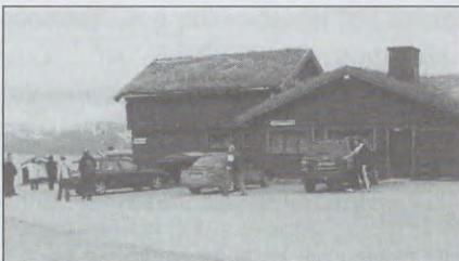
Ryc. 7. Tradycyjne materiały, darń i trawa jako współczesne pokrycie dachów na obiektach obsługi komunikacji samochodowej w rejonie Lilsberg w Środkowej Norwegii. Fot. autor – 2008 r.
