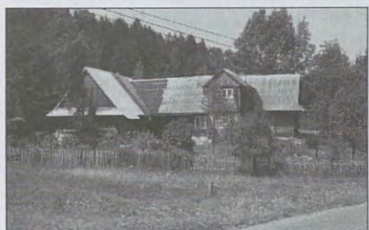
Ryc. 5. Przebudowana „długa chałupa” Górów z Korbielowa, fotografia własna autora.
