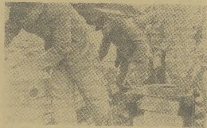
Przodująca brygada murarska KZWME
