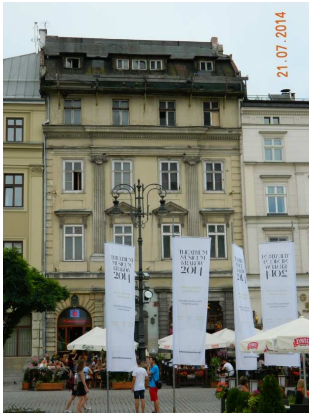
Fot. nr 65 (65-66). Kamienica Turowska pod nr 22, której remont od lat uniemożliwia właściciel.
