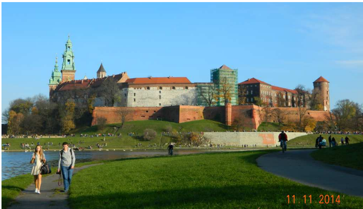
Fot. nr 335 (335-348). Widoki wzgórza wawelskiego z prawego brzegu Wisły, w dół od mostu Dębnickiego. Fot. nr: 335-336. Widoki spod mostu.
