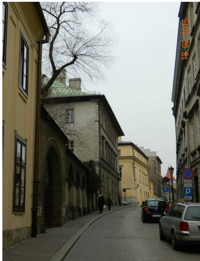
Fot. nr 210. Widok z ulicy Siennej.
