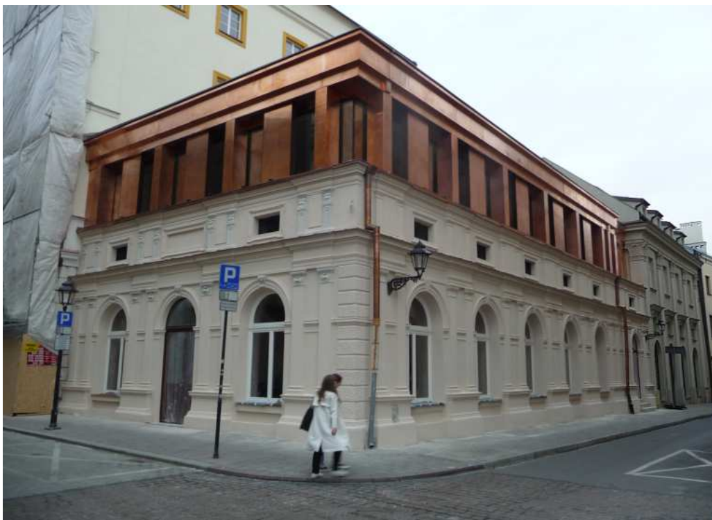
Fot. nr 169. Dobudowane właśnie I piętro do pawilonu gastronomicznego pod nr 2. (03.09.2014)
