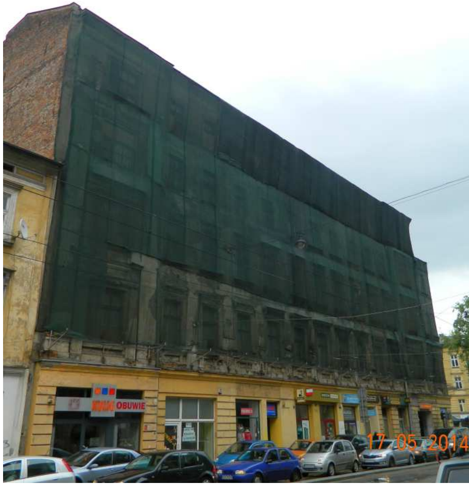
Fot. nr 356 (356-357). Kamienica spod nr 18/Dietla 44 wg stanu sprzed remontu
