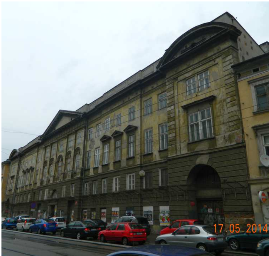
Fot. nr 355. Dawny gmach Dowództwa Twierdzy Kraków pod nr 12-14 przed remontem.
