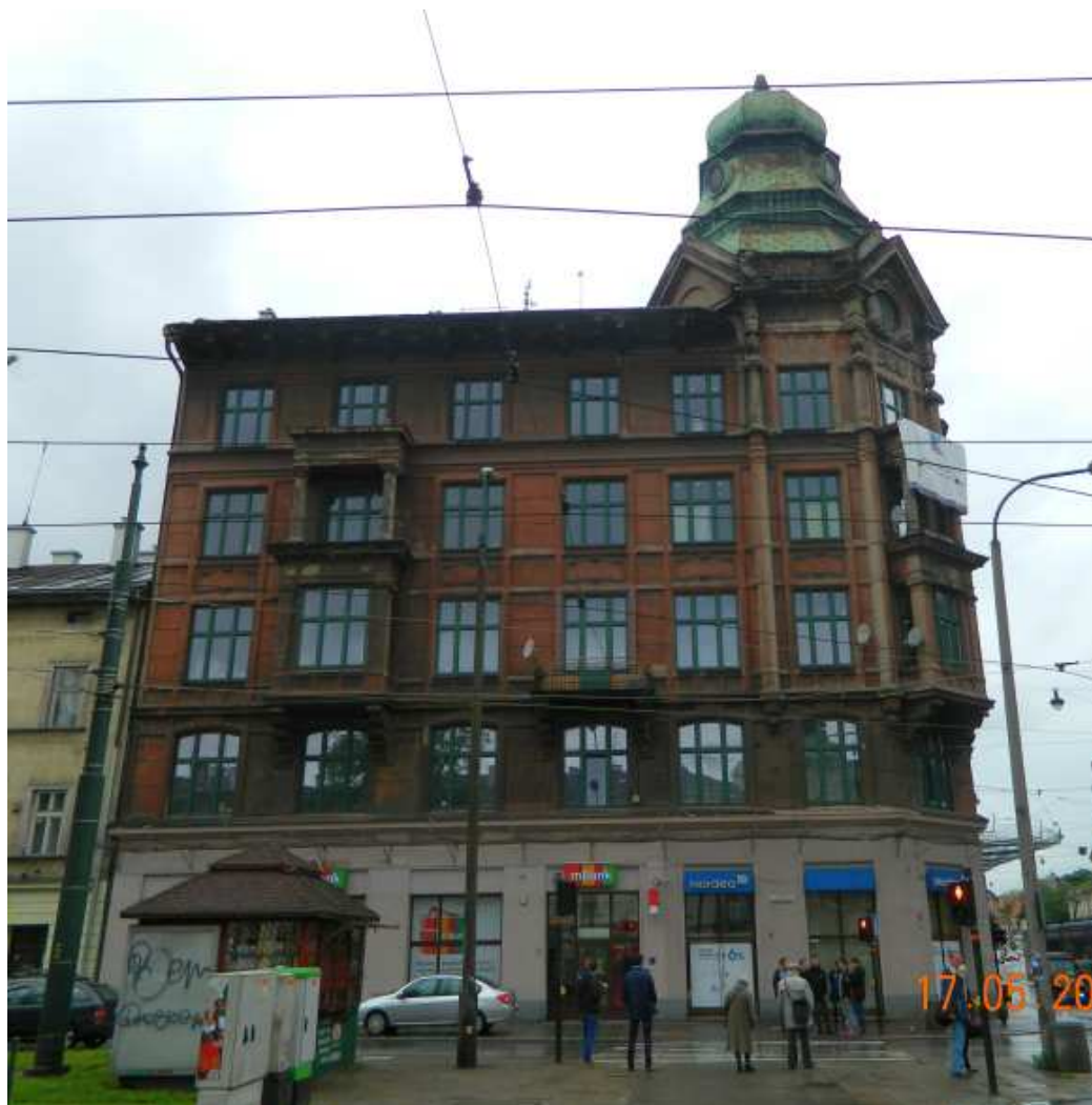
Fot. nr 358. Kamienica Ohrensteina spod nr 27/Dietla 42. Widok z ulicy Dietla.
