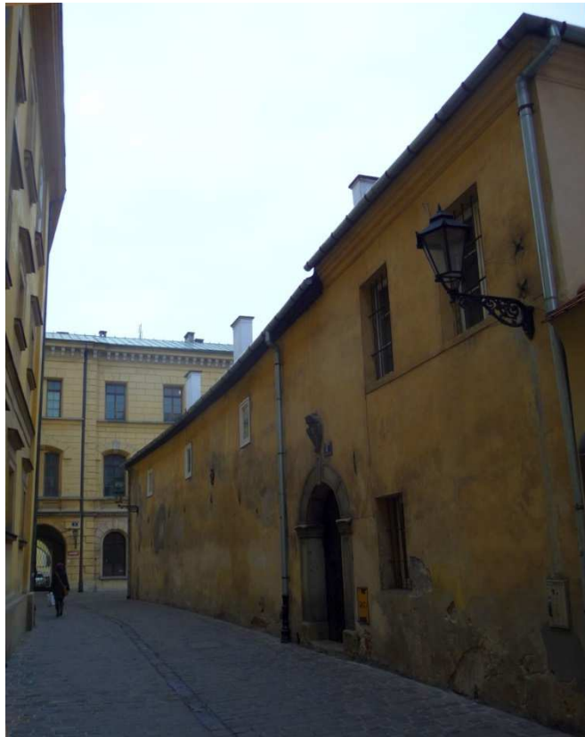
Fot. nr 267. Załek przy ulicy Senackiej w ujęciu z wylotu ulicy Kanoniczej. (16.01.2014)
