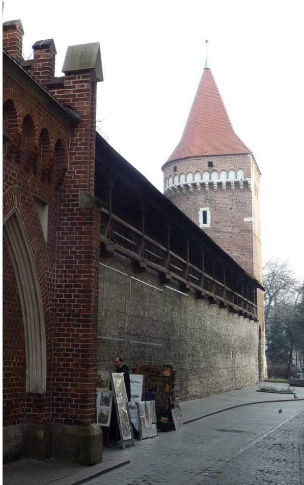
Fot. nr 198. Wschodni fragment murów z Basztą Pasamoników w tle. (17.01.2014)
