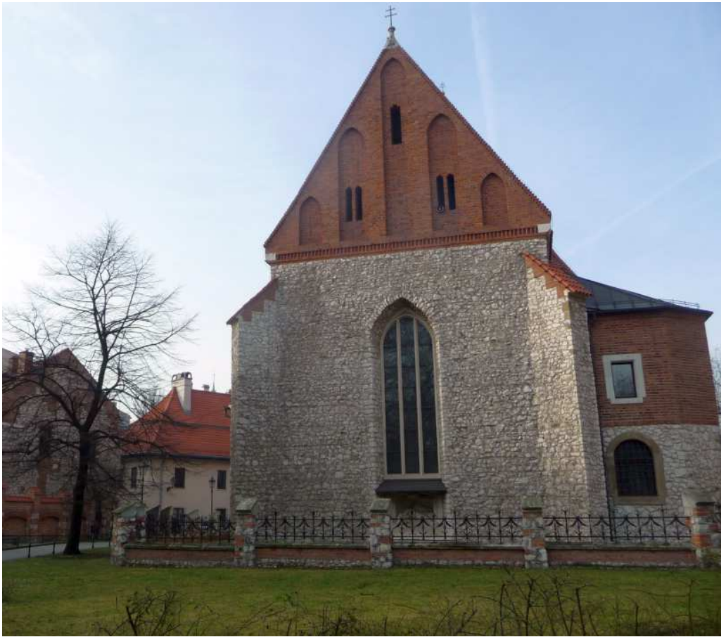
Fot. nr 207. Prezbiterium kościoła św. Krzyża w ujęciu z Plant. (17.01.2014)
