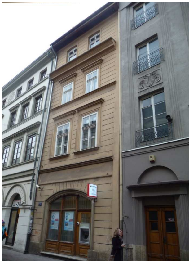
Fot. nr 176. Kamienica pod nr 3 po dobudowaniu trzeciego piętra. (11.04.2014)
