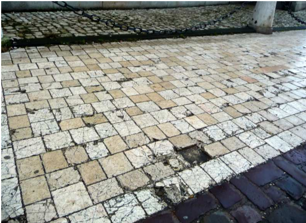
Fot. nr 236. Różne typy wapiennej kostki pod ścianą boczną kościoła Mariackiego: w głębi oryginalne, rodzime kocie łby, bliżej zaś rozsypujący się na mrozie współczesny turecki wapień. (11.02.2014)
