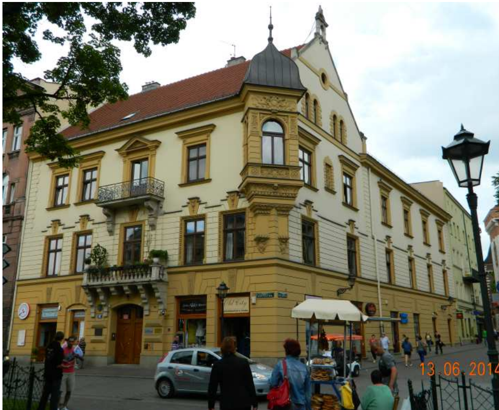
Fot. nr 206. Eklektyczna kamienica pod nr 40 w narożu z ulicą Pijarską.
