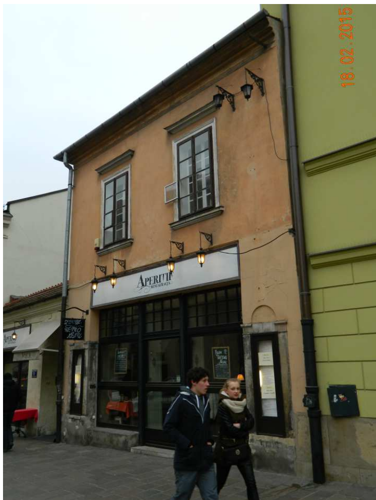
Fot. nr 219 (219-220). Dom pod nr 9 z oryginalną elewacją sprzed 150 lat.
