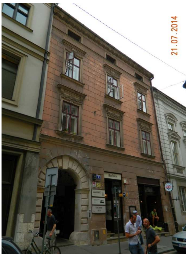
Fot. nr 163. Galicyjska duchem kamienica spod nr 4, jeszcze z oryginalnymi oknami.
