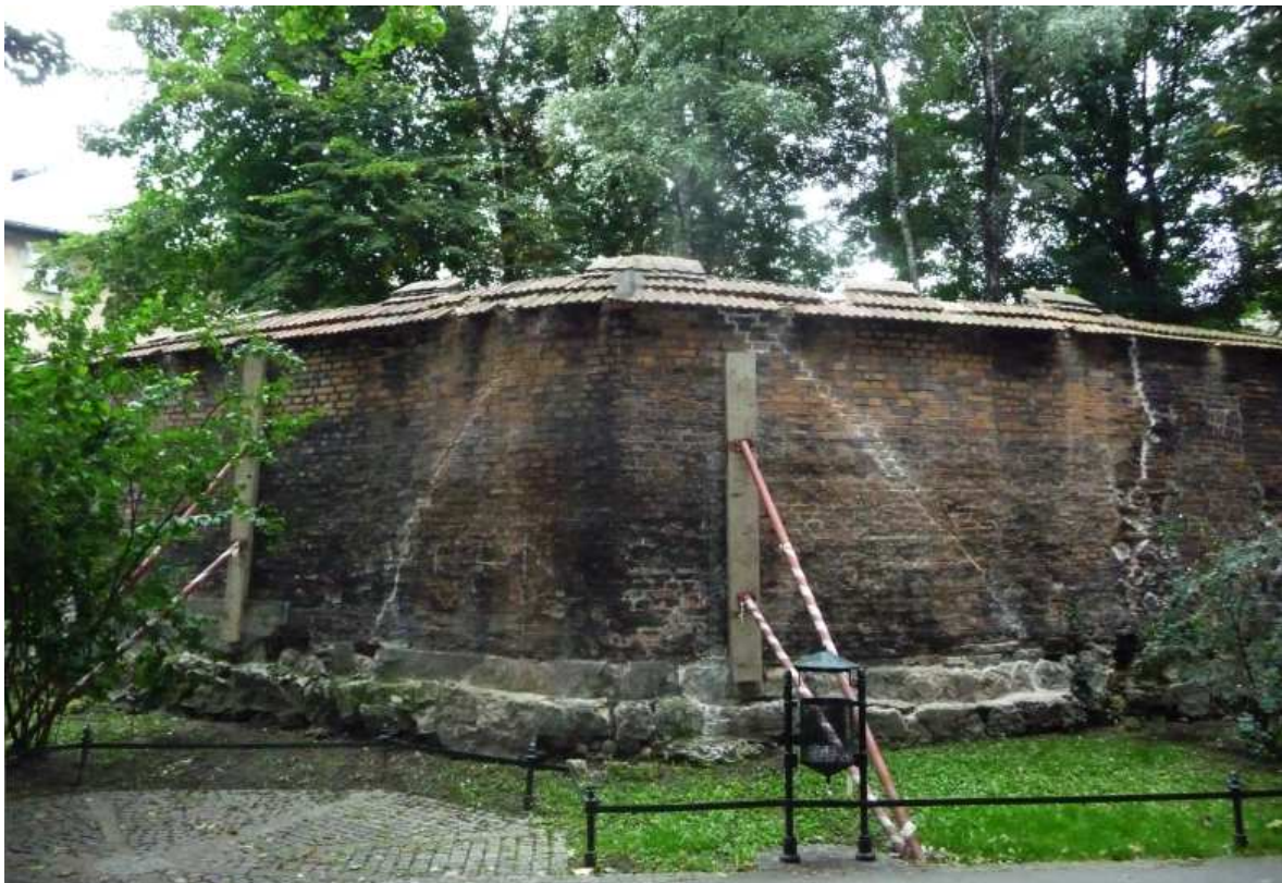
Fot. nr 2 (2-3). Mur klasztoru Reformatów na etapie naprawy. (03.09.2014)
