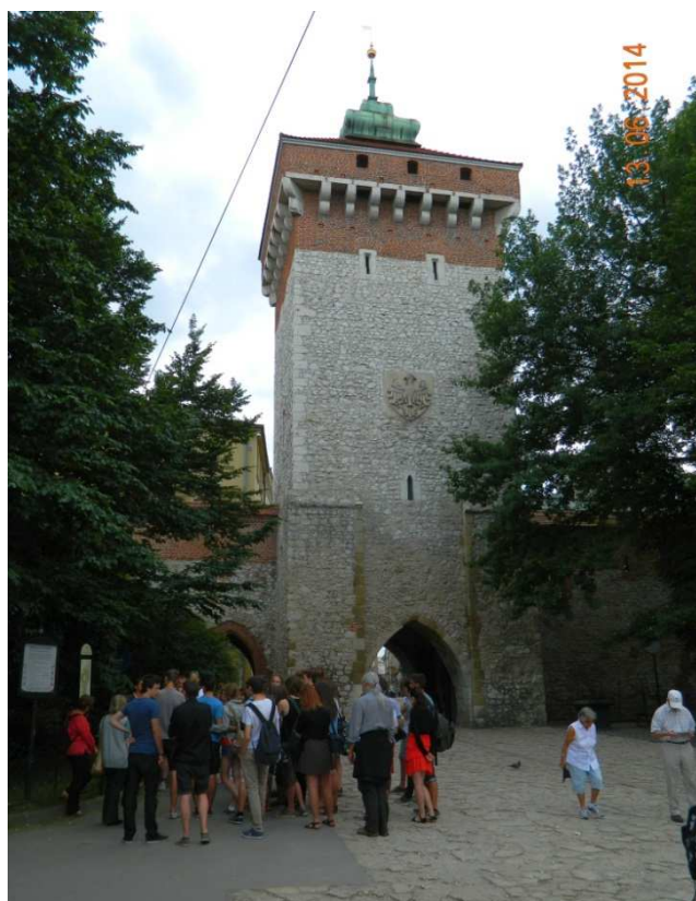
Fot. nr 17. Widok od strony Barbakanu.
