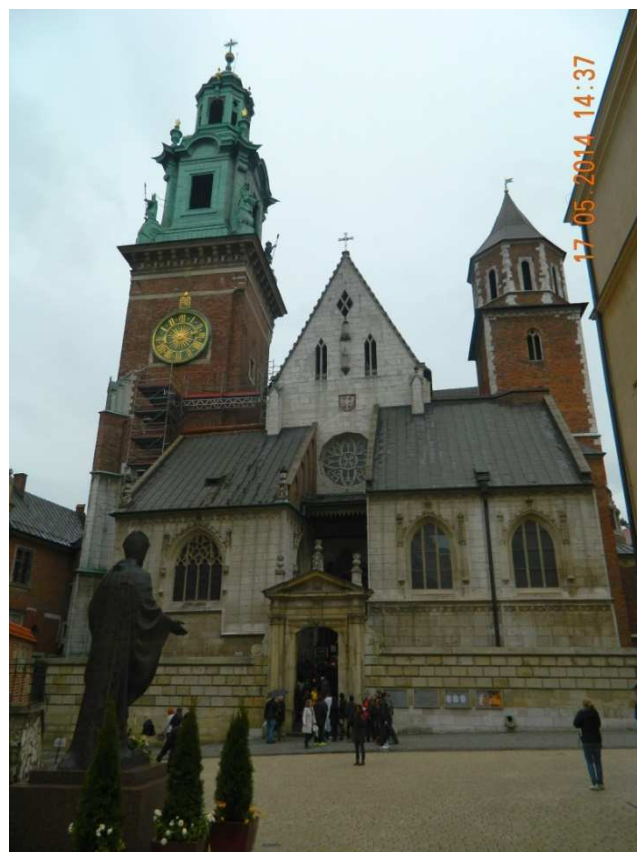
Fot. nr 315. Fasada katedry od strony zachodniej z kaplicami: Świętokrzyską i św. Trójcy.
