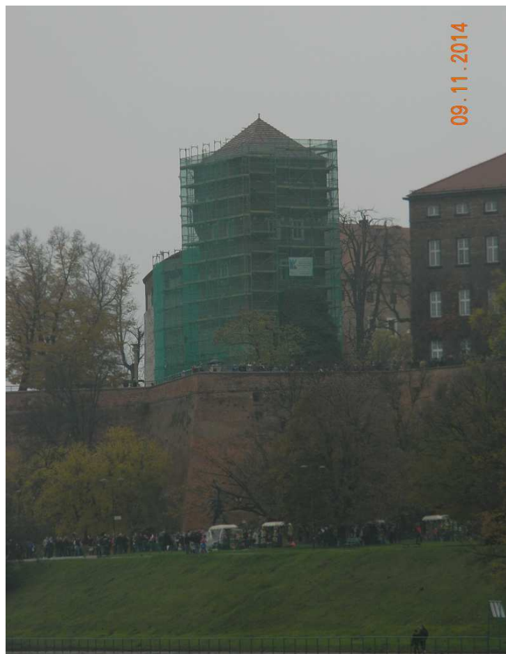
Fot. nr 341. Baszta Złodziejska na etapie remontu i przywracanie jej graniastego daszku.
