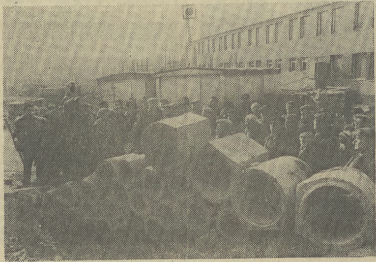
DYREKTOR Tadeusz Blachut pokazuje budowę hali sportowej. Fot. Stanisław Makarewicz
