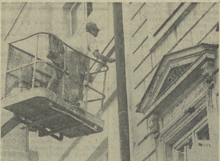
Odnawiamy „Drogę Królewską”. Na zdjęciu – malowanie elewacji budynku przy ul. Floriańskiej.
