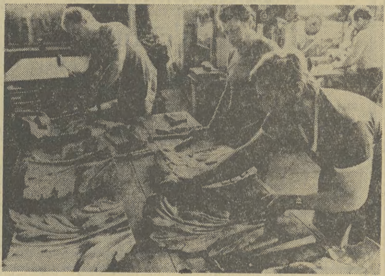
W najpiękniejszej budowli barokowej Drezna — Zwingerze trwa renowacja Bramy Koronnej. Brama ta została zaprojektowana w okresie panowania Augusta Mocnego i jest dziełem M. D. Poepelmana. Na zdj.: złotnicy restaurują elementy Bramy. CAF — ADN
