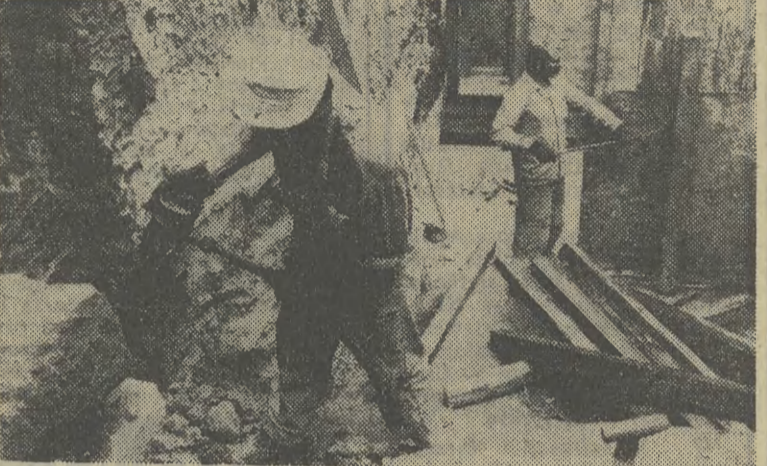
Trwa remont „Blokady”, domu studenckiego Akademii Rolniczej przy ul. Ziały. Na dwóch budynkach wznosi się nadbudówka IV piętra, a od strony ul. Czapskich buduje się nowy obiekt. Jest już ława fundamentowa...
