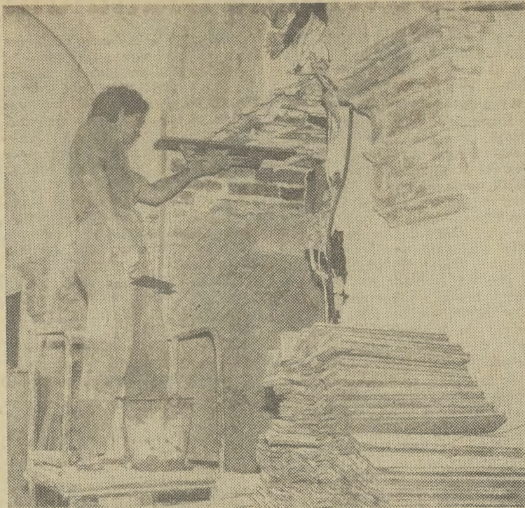
Murarz Szczepan Madej z PBS „Budostal” tynkował wczoraj wnękę drzwiową.
