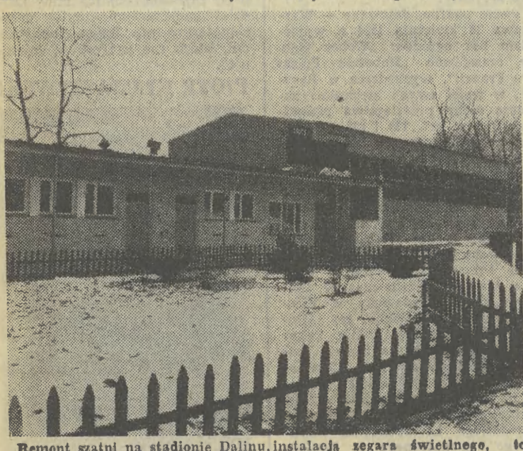
Remont szatni na stadionie Dalinu, instalacja zegara świetlnego, to wszystko zajęło 3 tygodnie. Fot. STANISŁAW MAKAREWICZ
