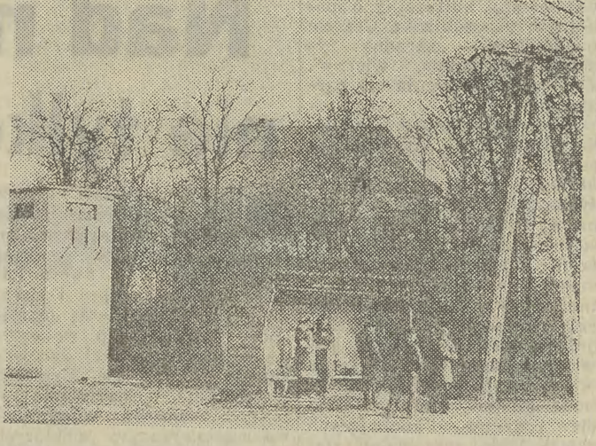
GRABOSZYCE. Skandaliczna lokalizacja stacji transformatorowej, słupa sieci energetycznej i przystanku PKS-u przed renesansowym dworem obronnym. Fot. Andrzej Gaczol
