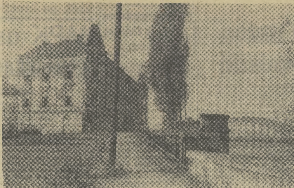
Widok na przyczółek kamiennego mostu i dom Aleksandrowicza na rogu ul. ul. Przy Moście i Brodzińskiego.
