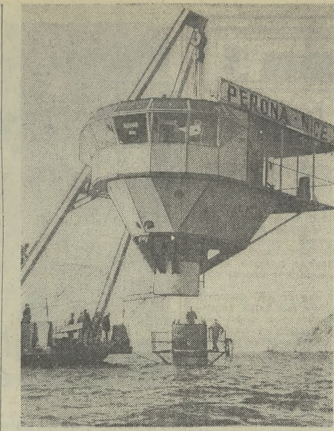
Villefranche-sur-Mer (Francja) — montaż wielkiej „głowicy” tzw. „Pływającej Wyspy” Cousteau, który prowadzi ma przy jej pomocy badania naukowe na morzu.
