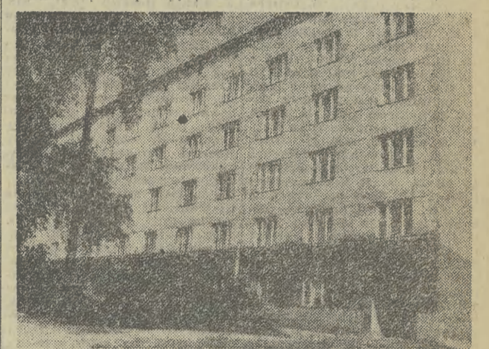
Ulica Parkowa 15 — pierwszy budynek Krakowskiej Spółdzielni Mieszkaniowej. Fot. Jadwiga Rubiś
