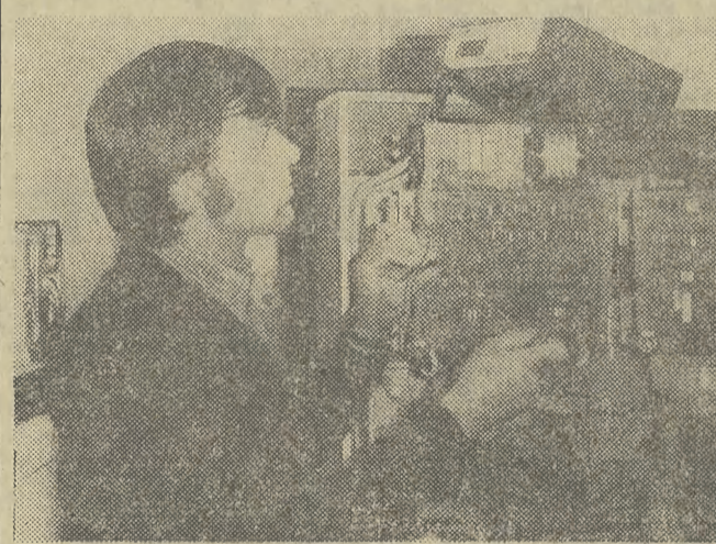
Elektrotechnik Józef Grzesiak przy instalowaniu komputera w nowym budynku.
