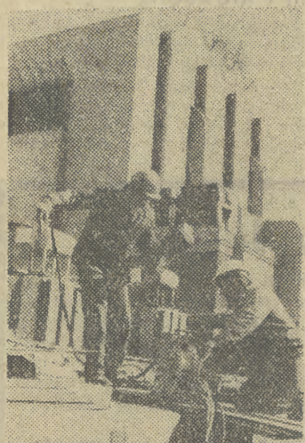
Na budowie II bloku energetycznego o mocy 500 MW w Elektrowni „Kozienice” trwają intensywne prace, poprzedzające wejście inwestycji w etap prób rozpalań. CAF — telefoto
