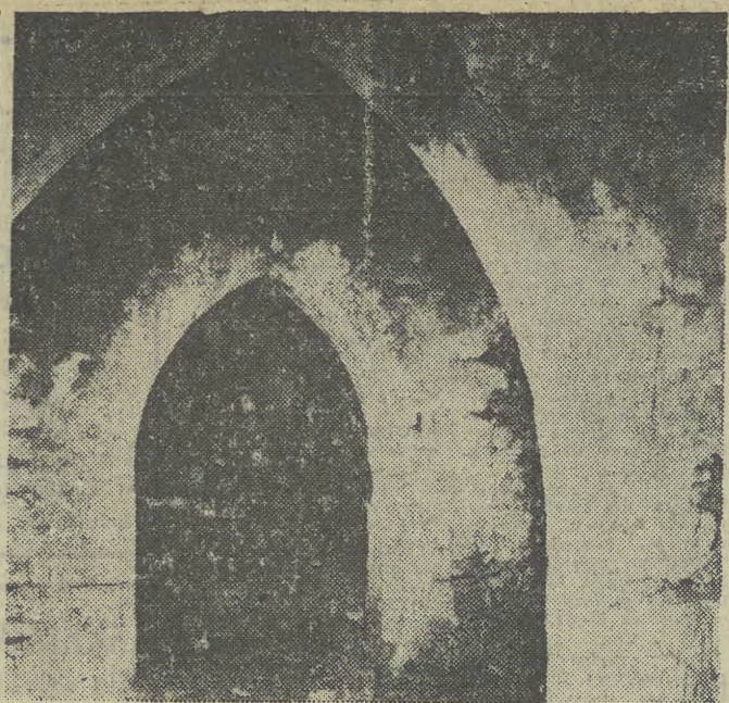
W piwnicach kamienicy zachowaly sie gotyckie fragmenty murow i kamieniariki.
