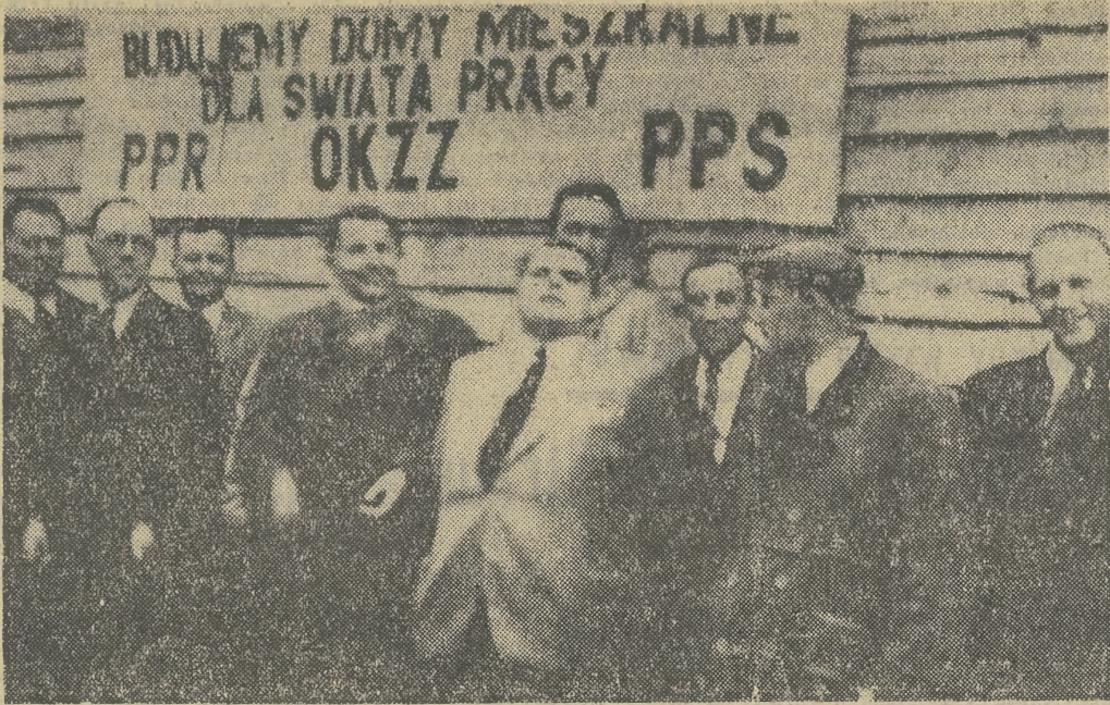
Pamiętkowa fotografia działaczy OKZZ i Spółdzielni wykonana w kwietniu 1948 r. na placu budowy przy ul. 15 Grudnia.
