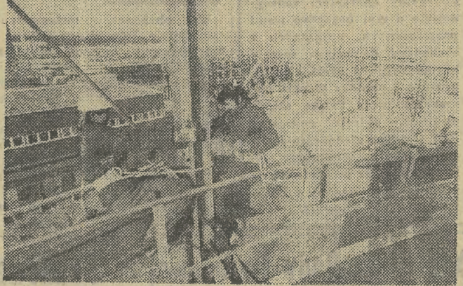
W Brzeziu koło Włocławka pow-staje wytwórnia polichloru winy-lu — surowca znajdującego coraz szersze zastosowanie w przemyśle i budownictwie. CAF — ŻOLNOWSKI
