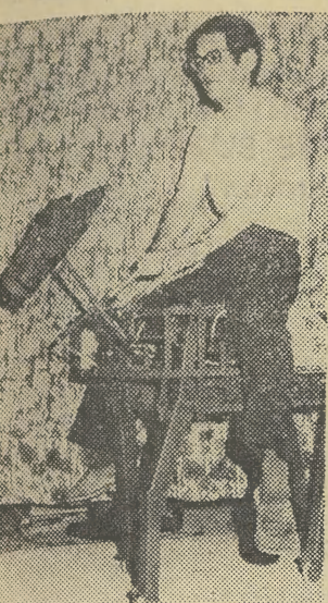
Widoczny na zdjęciu robot w formie konia z napędem elektrycznym (z akumulatora samochodowego) jest dziełem mieszkanki Tokio, którego hobby — to konstrukcja mniej i bardziej skomplikowanych robotów. 50-kilogramowy „koń” może unieść jeźdźcę o wadze do 75 kg i poruszać się z nim z szybkością... 2 km/godz. Fot. CAF — JPS
