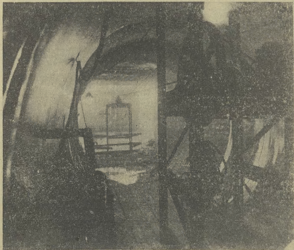
Wnętrze dolnej sztolni i rurociągu wodnego — w montażu.
