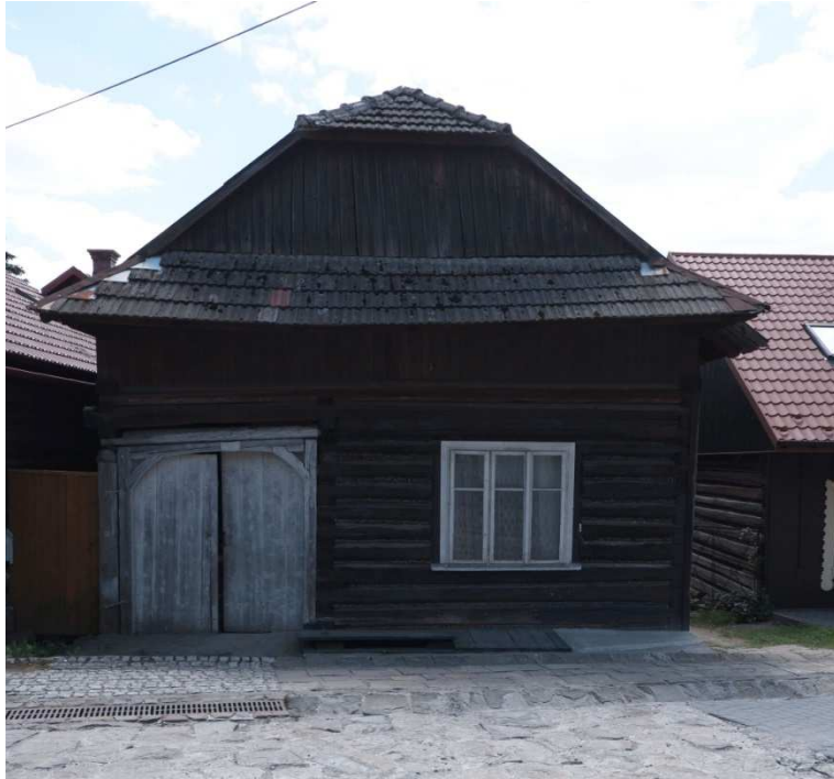
Fot. nr 216 (216-218). Oryginalny dom o konstrukcji zrębowej spod nr 37 (pierwotnie nr 126), który powstał w roku 1870, a więc rok po wielkim pożarze miasteczka.
