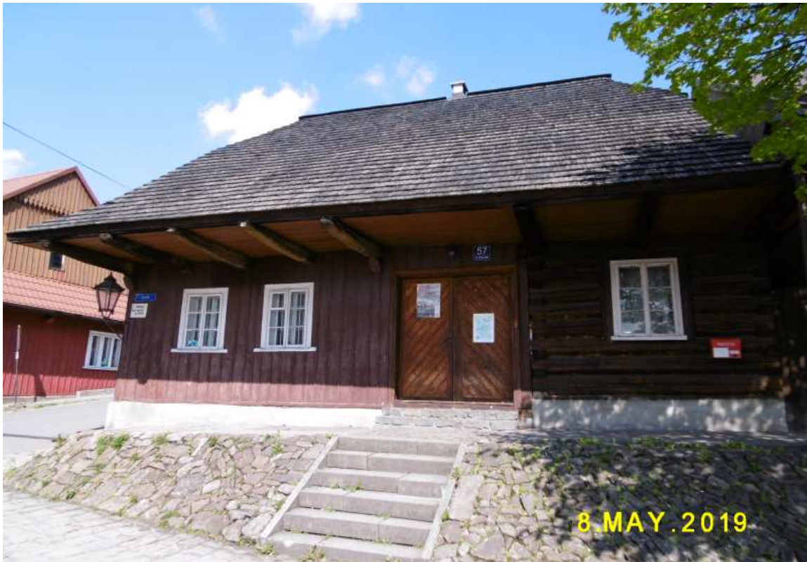
Fot. nr 85. Fasada od strony Rynku.
