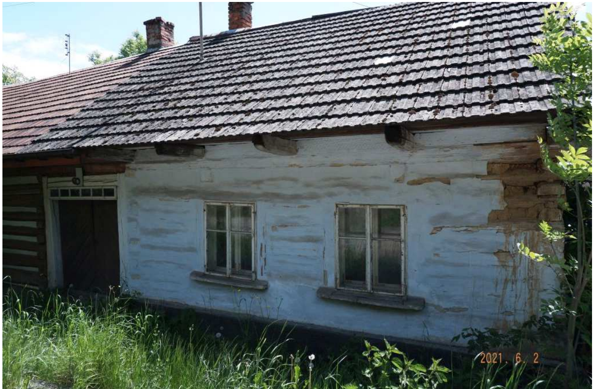
Fot. nr 294. Oryginalnie bielona prawa część z oknami typu ościeżnicowego.
