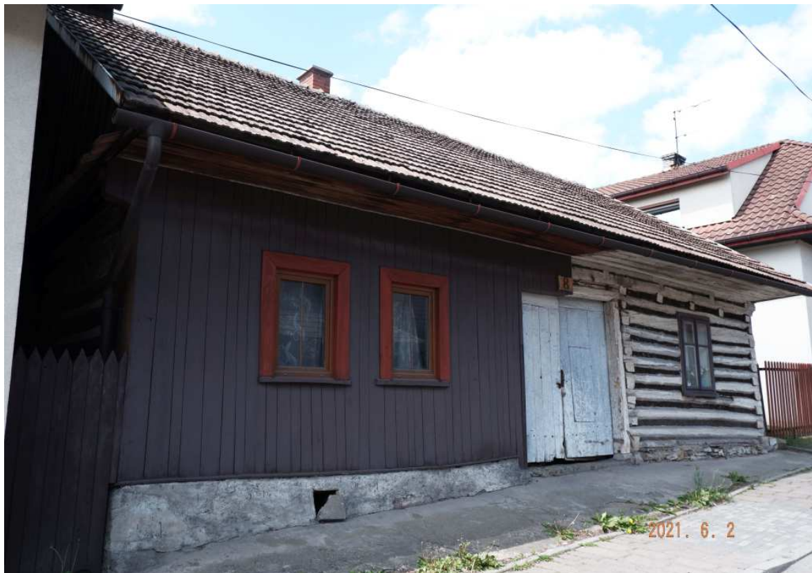
Fot. nr 339 (339-340). Częściowo już przebudowana chałupa spod nr 8 (pierwotnie nr 181), która najpewniej powstała w I ćwierci XX wieku.
