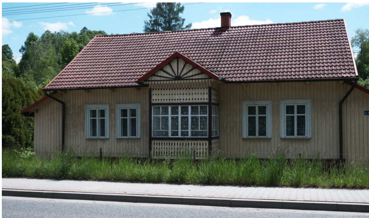
Fot. nr 400 (400-401). Widoki na fasadę.
