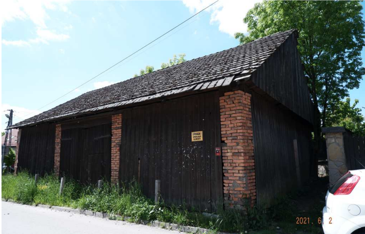
Fot. nr 326. Przykład drewnianej stodoły w narożu z ulicą Piłsudskiego, z wykorzystaniem cegły jako materiału konstrukcyjnego.
