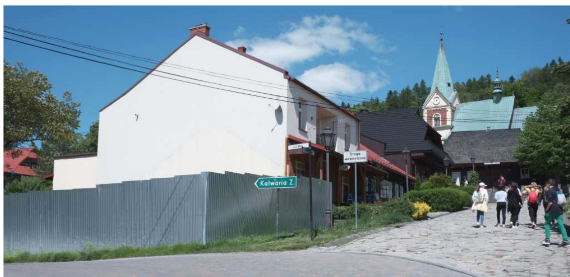
Fot. nr 223. Pusta przestrzeń pod nr 45 (pierwotnie nr 123) po wyburzonej w roku 2020, urzekającej swym pięknem „Aniołównie”, domu o konstrukcji zrębowej, który powstał w II poł. XIX wieku. Znikł pomimo wpisania go do rejestru zabytków, co trudno komentować.
