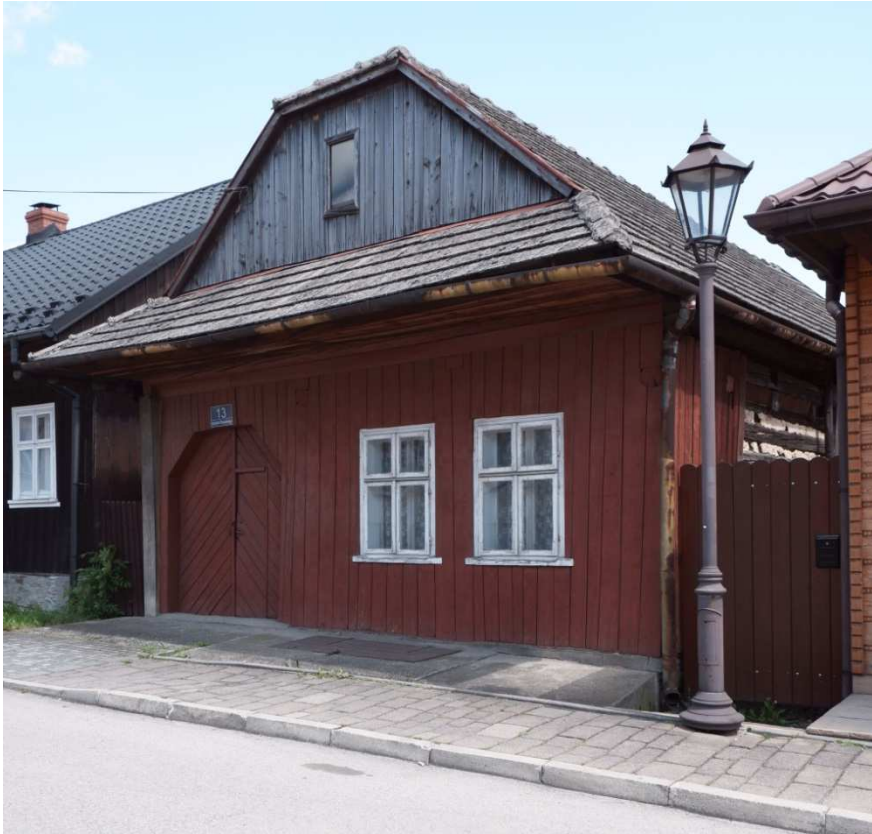
Fot. nr 338. Urokliwy dom o konstrukcji zrębowej, z okapowym dachem, spod nr 13 (pierwotnie nr 179), powstały w roku 1870. Oszalowanie i okna zapewne międzywojenne.
