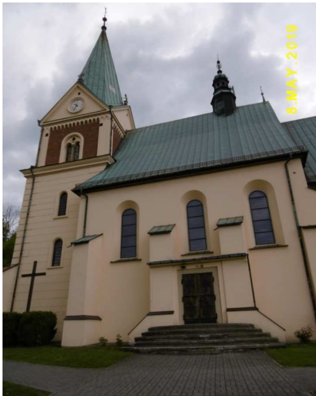
Fot. nr 168. Południowa ściana boczna nawy i wieża kościelna.
