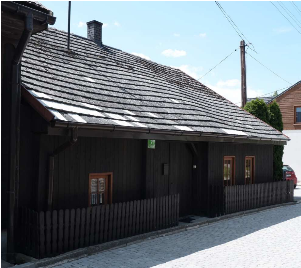
Fot. nr 350. Współczesna wersja fasady domu o konstrukcji zrębowej spod nr 7 (dawniej nr 197), który w oryginale (fot. poniżej) jest datowany na I połowę XIX wieku.
