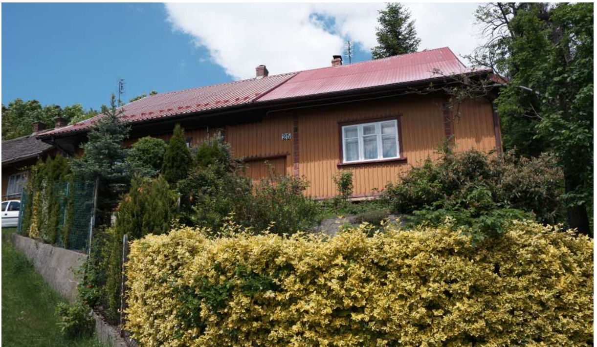
Fot. nr 277 (277-278). Obity szalunkiem dom pod nr 25 (pierwotnie nr 88), również datowany na I połowę XX wieku.
