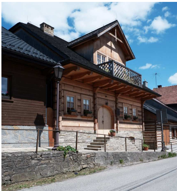
Fot. nr 257. Współcześnie przebudowany dom spod nr 3 (dawniej nr 112), pierwotnie pochodzący zapewne z II połowy XIX wieku. Obiekt nie znajduje się w GEZ.
