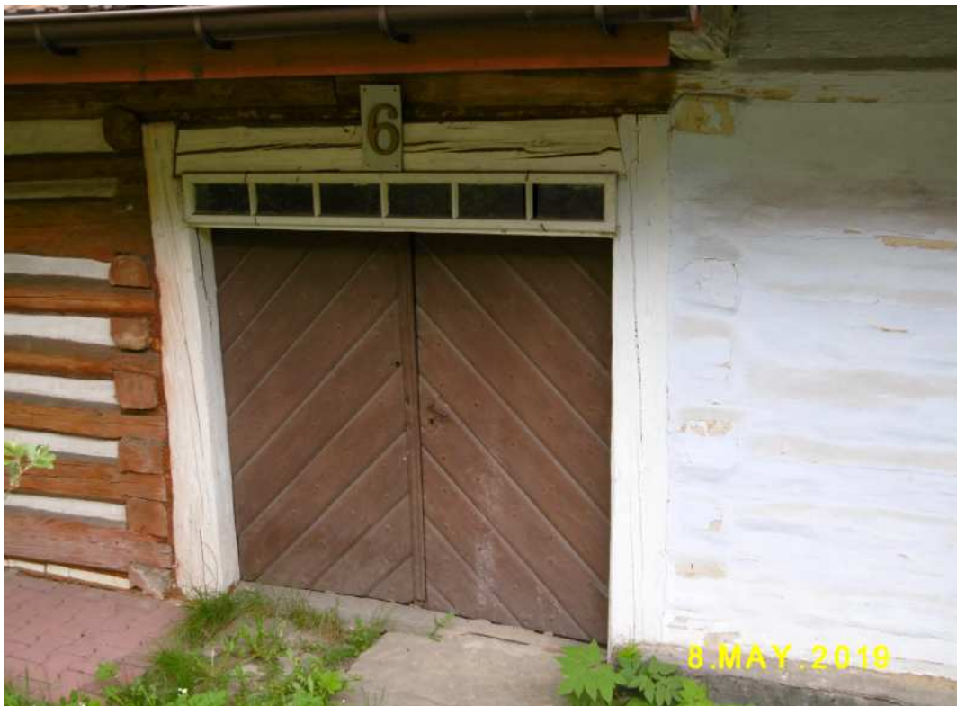
Fot. nr 203. Drzwi ze świetlikiem w ich zwieńczeniu.
