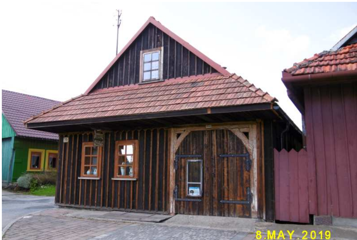
Fot. nr 132. Dom spod nr 16 (d. 194), datowany na I połowę XIX wieku, po współczesnej odnowie.
