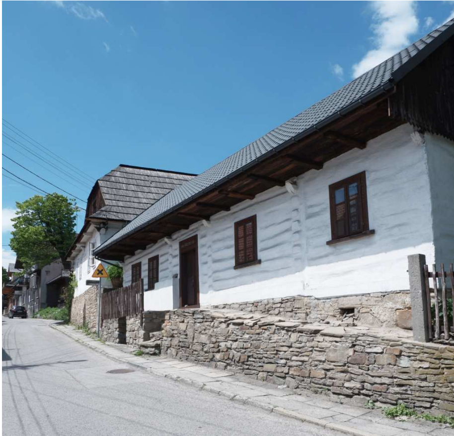
Fot. nr 266 (266-267). Dom o konstrukcji zrębowej spod nr 15 (pierwotnie nr 99), datowany na II połowę XIX wieku (prawdopodobnie 1855).
