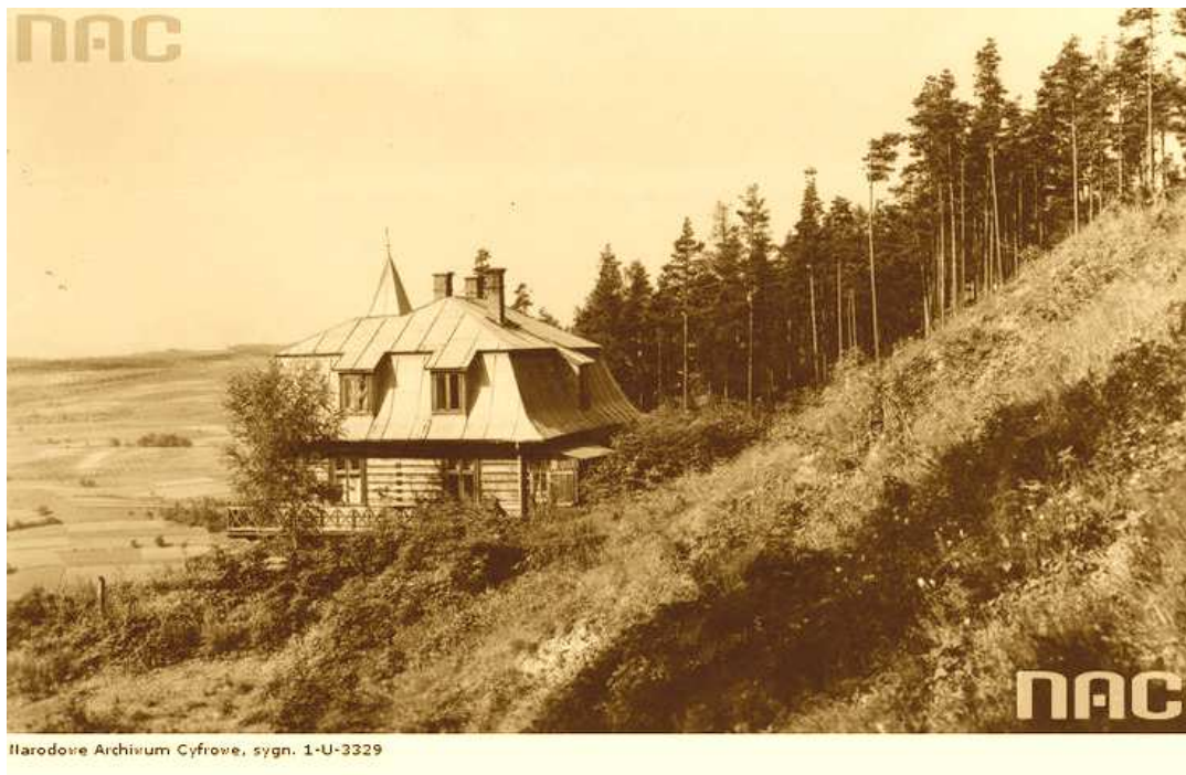
Fot. nr 12. Willa Pod Blachą, zlokalizowana w sąsiedztwie ulicy św. Jana, w ujęciu z lat międzywojennych. Dziś w jej miejscu stoi willa Pod Zamkiem.
