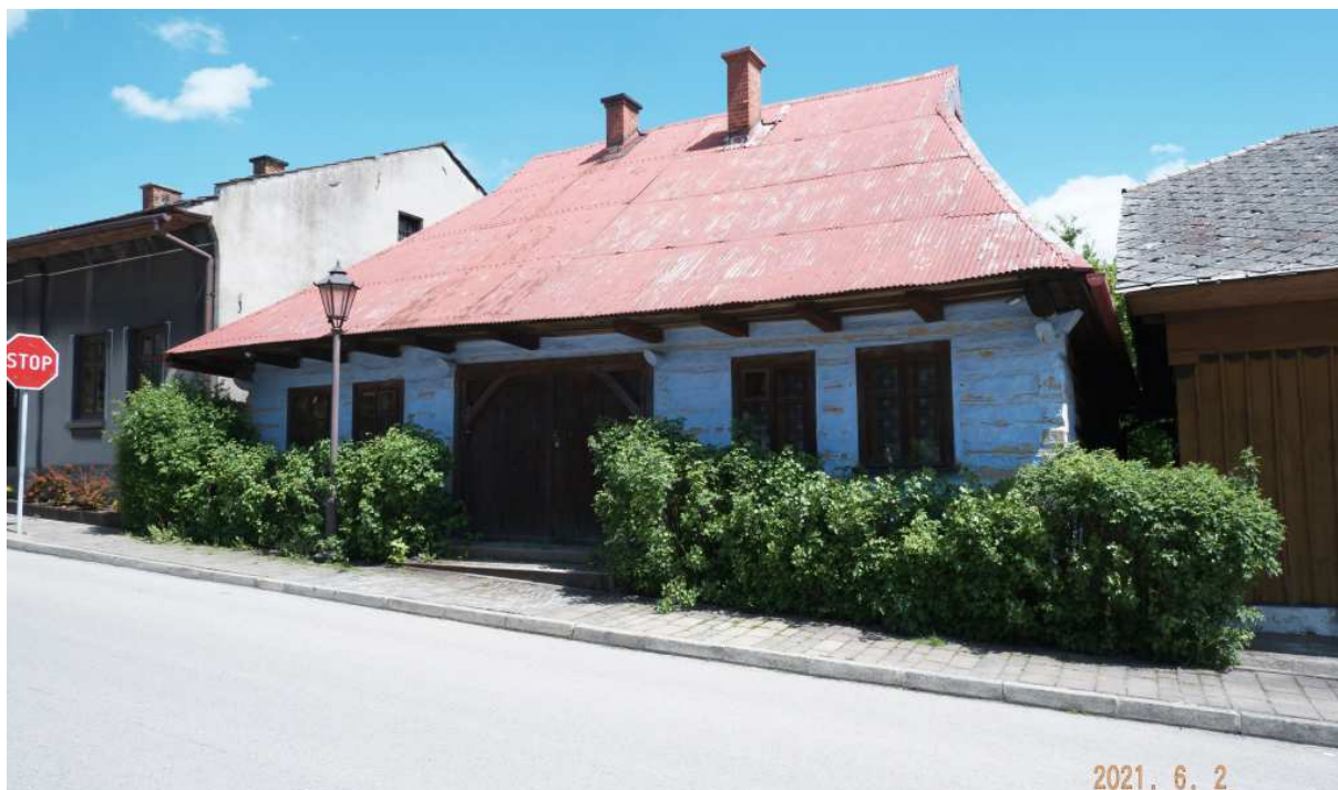
Fot. nr 331. Przepiękny dom o konstrukcji zrębowej spod nr 3 (pierwotnie nr 173), wybudowany w roku 1870. I tylko pokrycie dachowe do niego nie przystaje.
