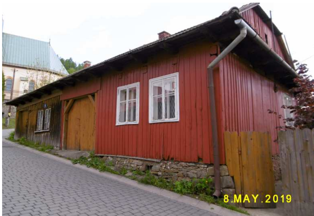
Fot. nr 162. Chałupy spod nr: 2 (d. 11) i 4 (d. 10), datowane na rok 1879.
