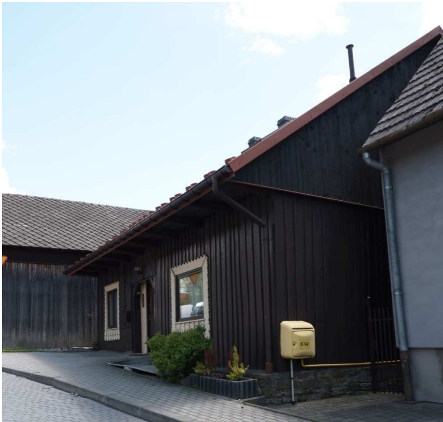
Fot. nr 369. Współcześnie zniekształcona fasada domu o konstrukcji zrębowej spod nr 1 (pierwotnie nr 223), który w dawnym oryginale powstał w roku 1855.
