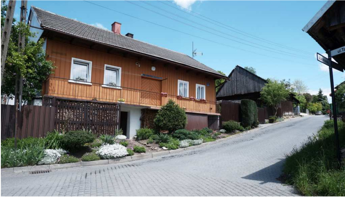
Fot. nr 362. Wzdłuż ulicy Jagiellońskiej ku Rynkowi w ujęciu z wylotu ulicy Targowej.
