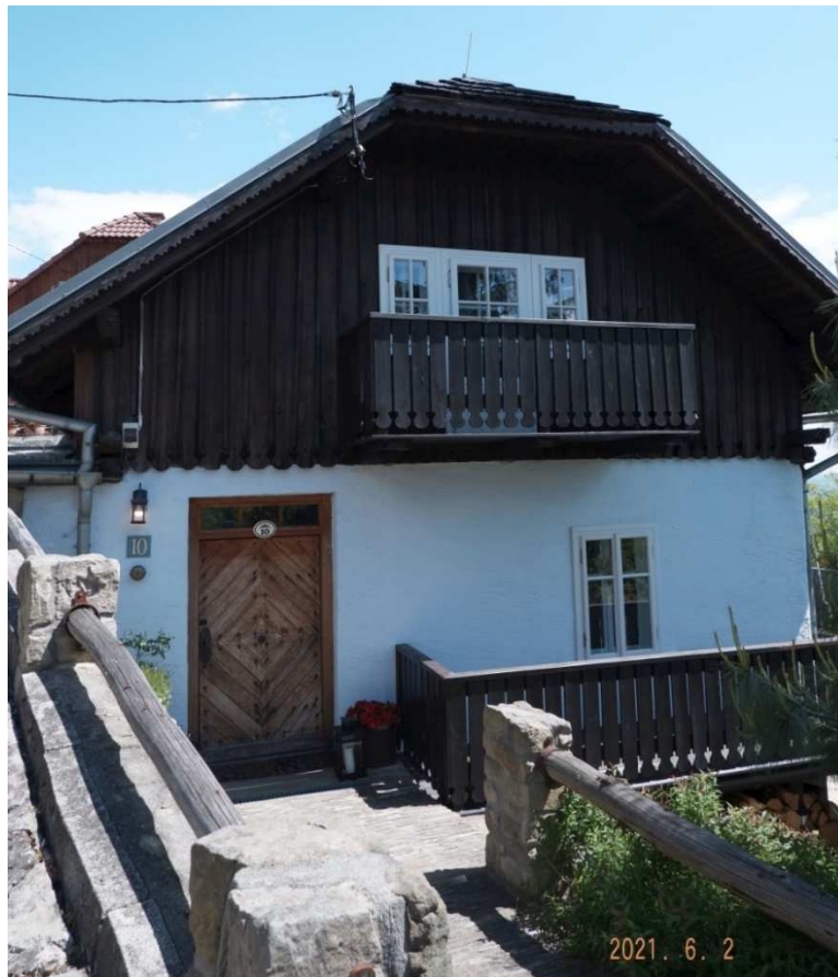
Fot. nr 301. Bliska oryginałowi ściana boczna przebudowanego domu o konstrukcji zrębowej spod nr 10 (pierwotnie nr 31), datowanego na przełom XIX i XX wieku.
