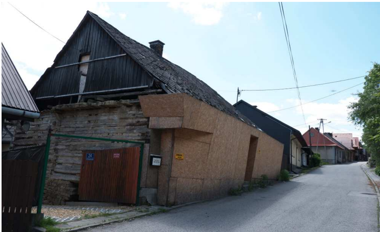
Fot. nr 271. Chałupa spod nr 22 (pierwotnie nr 92), powstała w roku 1855, na etapie remontu bądź przebudowy.
