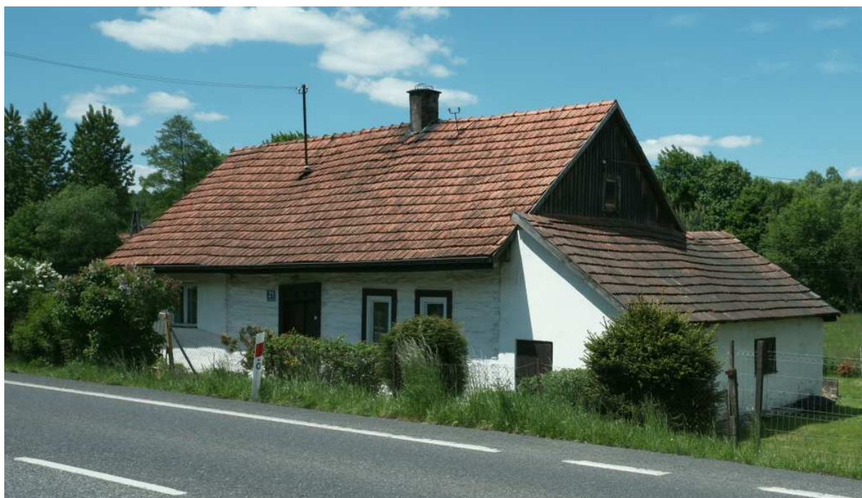
Fot. nr 411. Bielona jeszcze chałupa, z przylegającą do niej dawną stajnią. Niestety współczesne, plastikowe okna, bez zaznaczonych dawnych podziałów, wyraźnie psują jej obraz.
