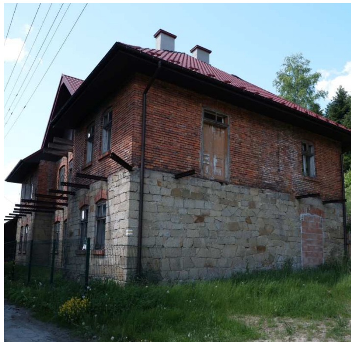
Fot. nr 315. Fasada i boczna ściana.
