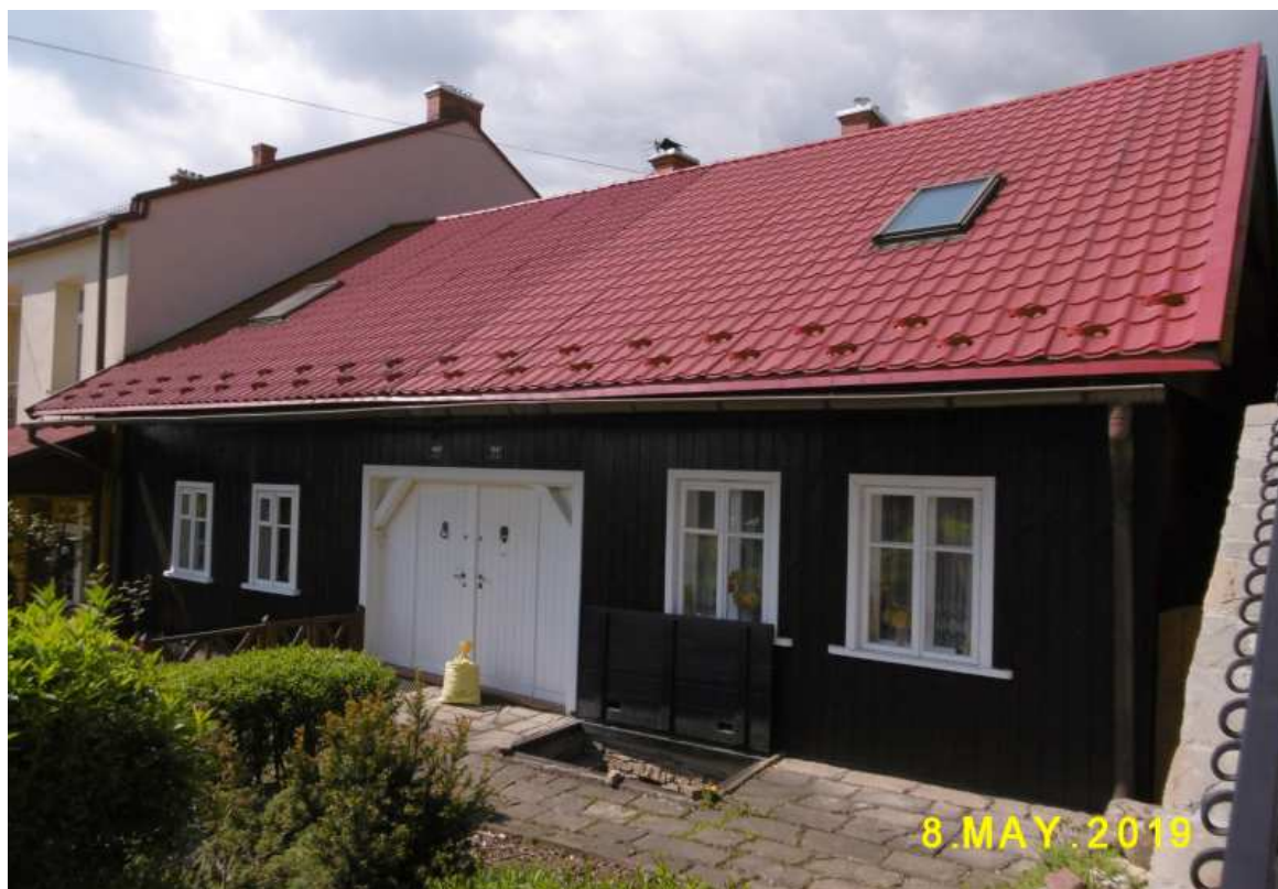
Fot. nr 76. Domy spod nr: 49-51 (dawniej 121) z II połowy XIX wieku.
