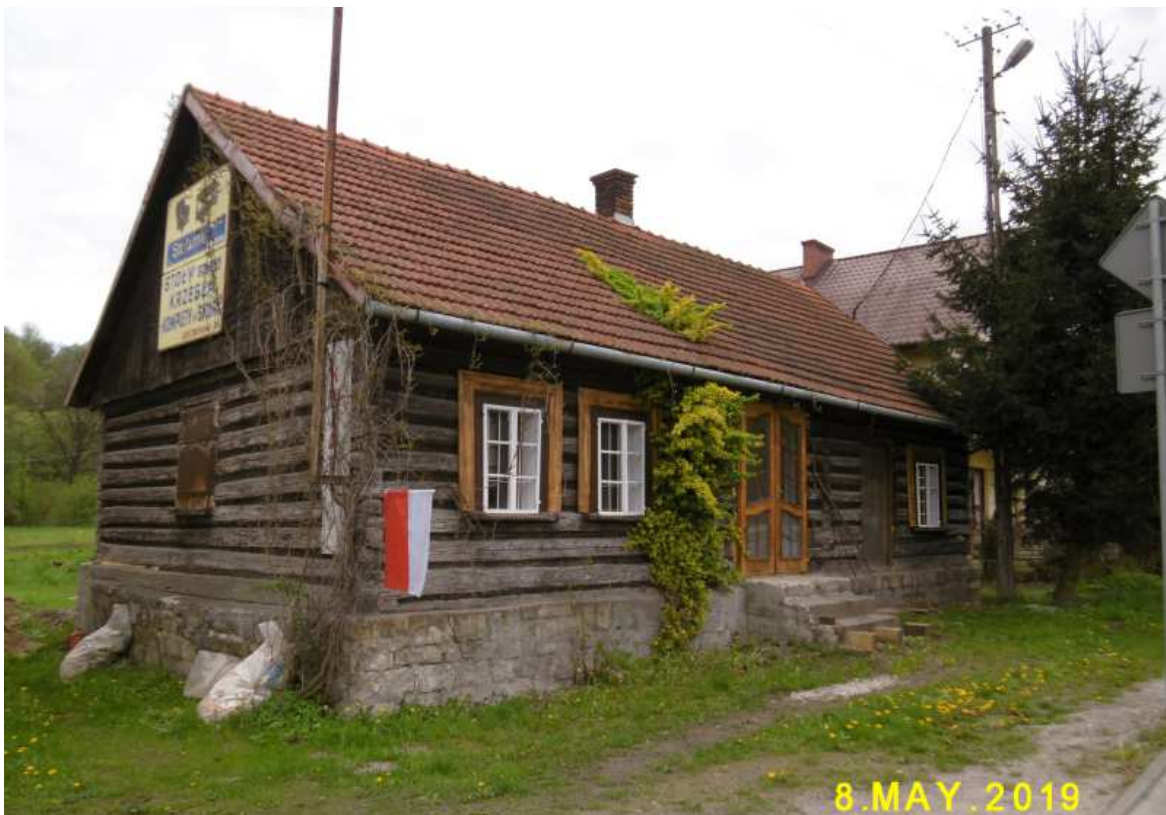
Fot. nr 389 (389-390). Bliski oryginałowi dom o konstrukcji zrębowej przy ulicy Krakowskiej pod nr 10, który zapewne powstał jeszcze w XIX wieku. Tylko współczesne drzwi burzą nieco urok fasady.
