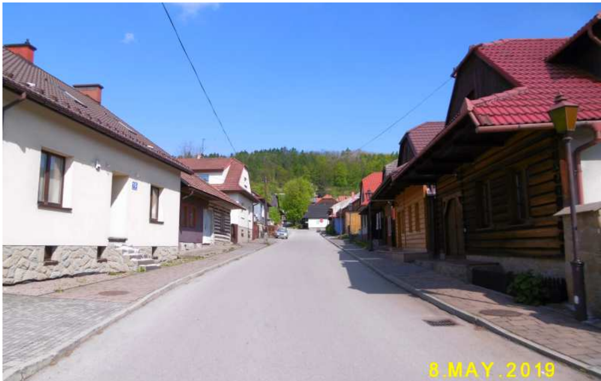
Fot. nr 130. Widok od strony ulicy Targowej ku Rynkowi.
