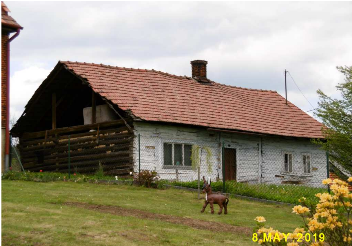
Fot. nr 392. Zapewne jeszcze XIX-wieczna, tradycyjnie bielona chałupa o konstrukcji zrębowej spod nr 228.
