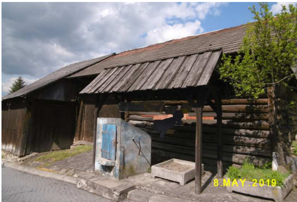
Fot. nr 143 (143-146). Archaiczna stodoła z posesji pod nr 12 (?) – dawniej 210 i jej detale.
