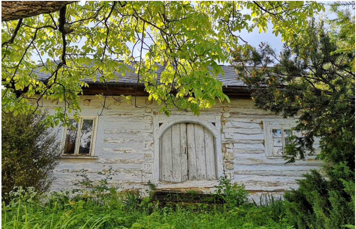
Fot. nr 360 (360-361). Oryginalna chałupa o konstrukcji zrębowej spod nr 14 (pierwotnie 209), która została wybudowana w roku 1884. Fot. Przemysława Wesołowskiego. (maj 2021).
