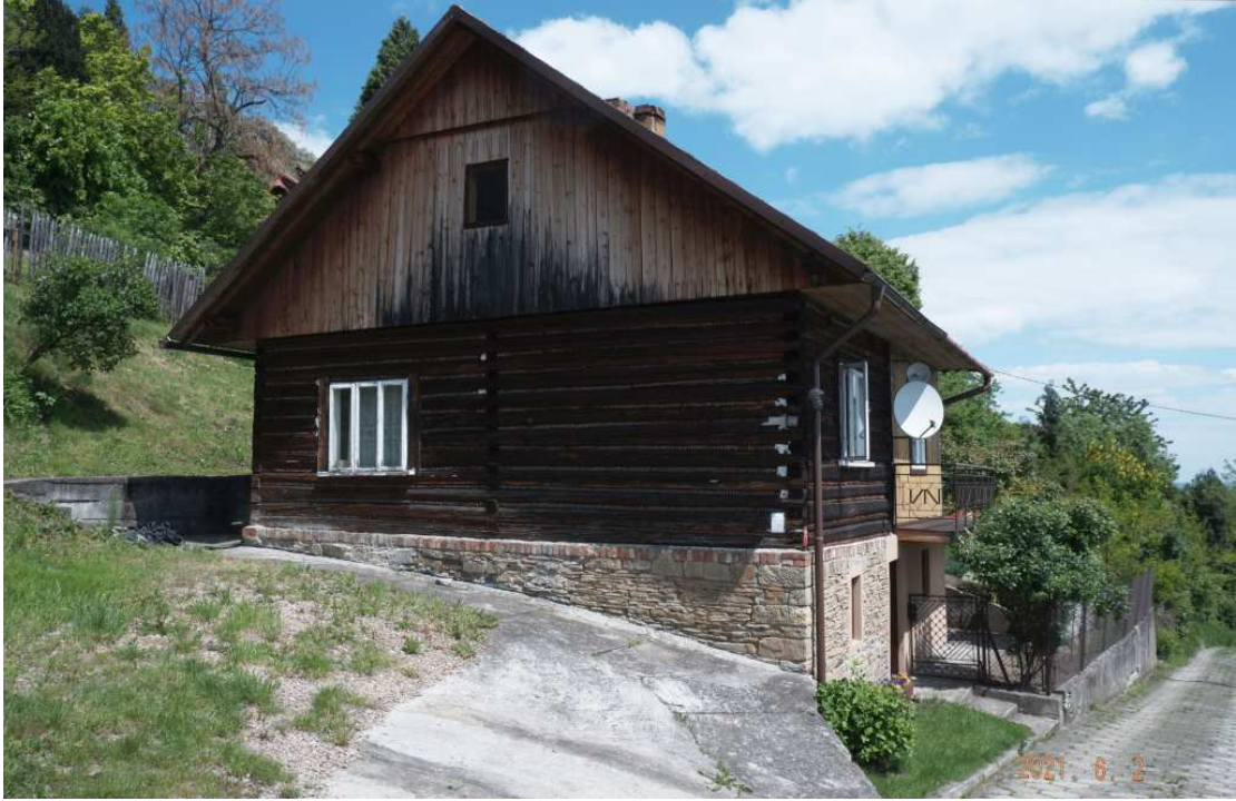
Fot. nr 322 (322-323). Dom pod nr 9 (pierwotnie nr 45), w którym drewniane bale są uszczelnione warkoczami słomy. Wg GEZ powstał w I połowie XIX wieku.
