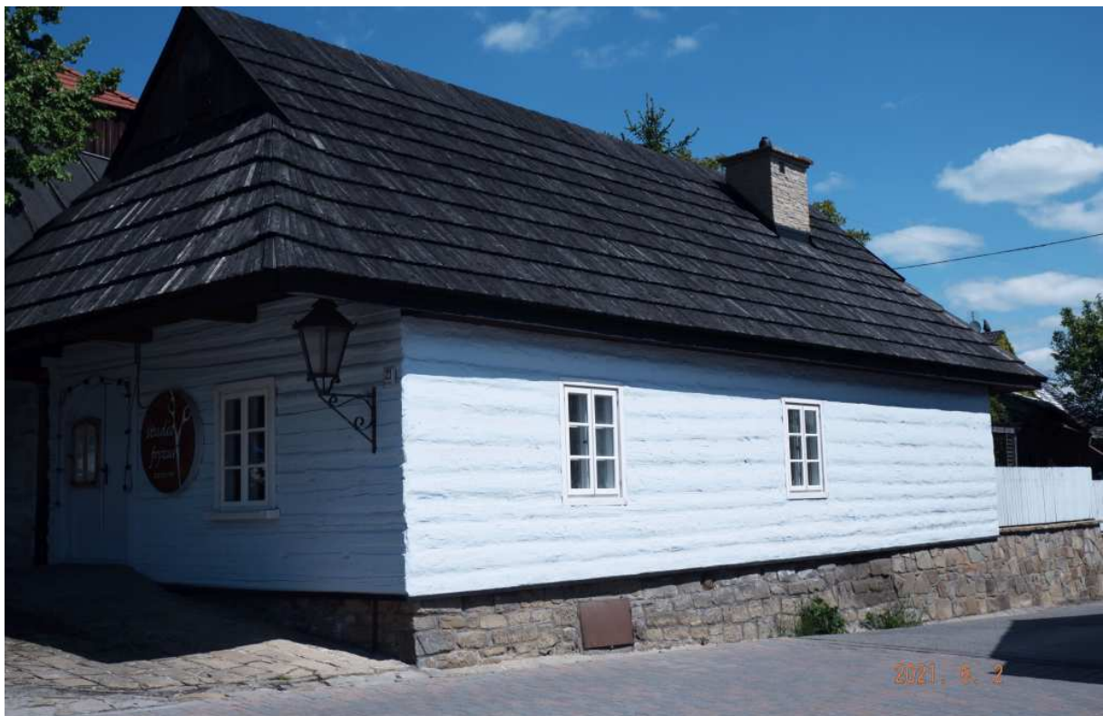
Fot. nr 253. Dom spod nr 21 (pierwotnie nr 143), w narożu z ulicą Krakowską, w oryginale pochodząca zapewne z przełomu XVIII i XIX wieku, wg GEZ przebudowany w roku 1895. Dziś mieści się w niej Izba Regionalna.
