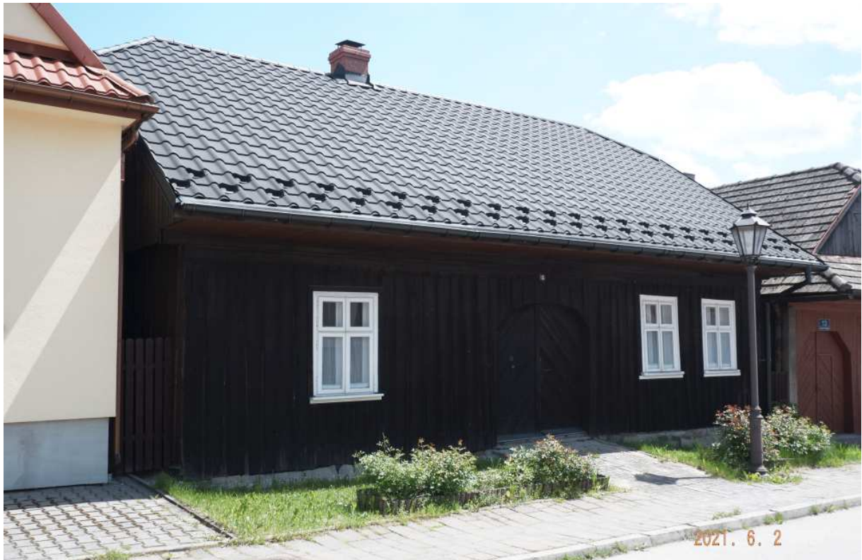
Fot. nr 336 (336-337). Dom o konstrukcji zrębowej spod nr 11 (pierwotnie nr 178), z charakterystyczną bramą posrodku, wybudowany w roku 1870, choć okna pochodzą zapewne z okresu międzywojennego.
