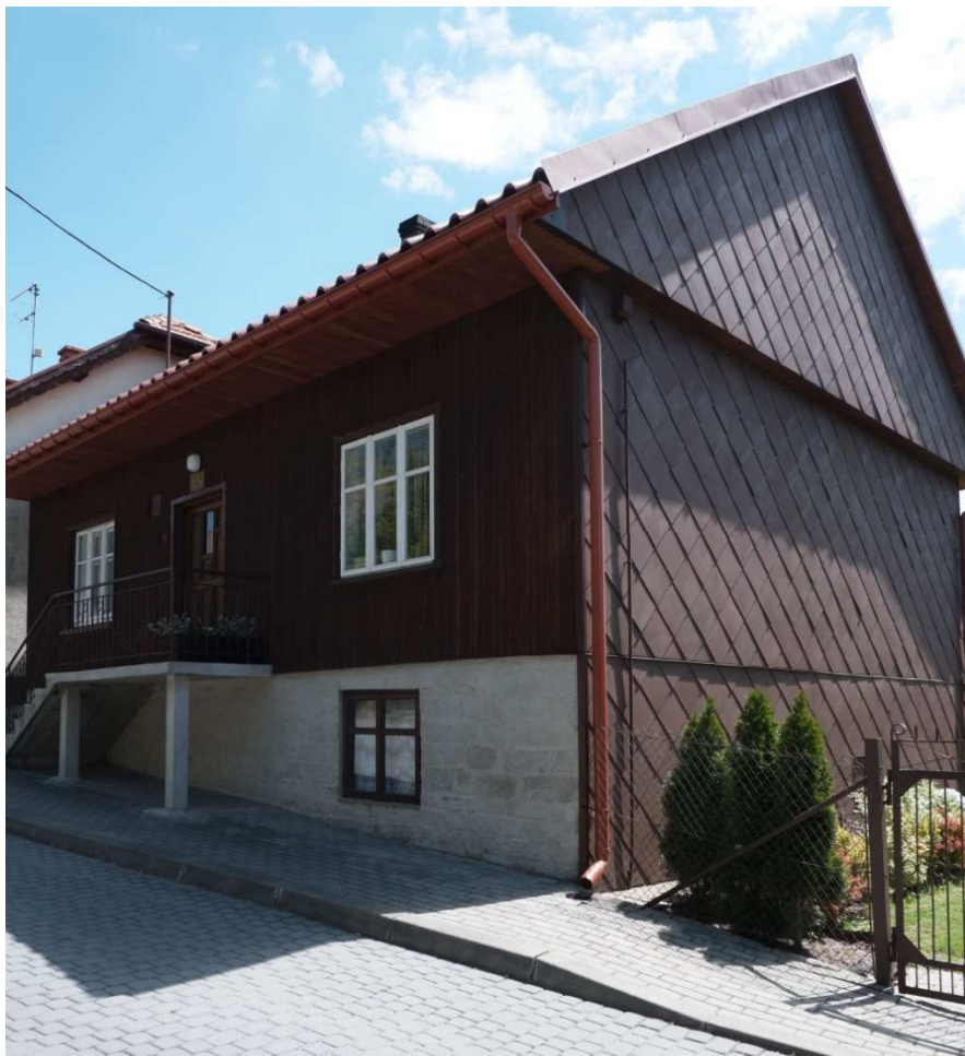
Fot. nr 366. Oszalowany dom o konstrukcji zrębowej spod nr 13 (pierwotnie nr 214), który powstał na początku XX wieku.
