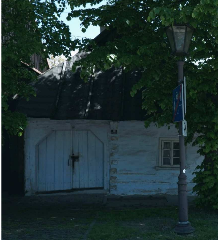
Fot. nr 252. Oryginał o konstrukcji zrębowej spod nr 19 (pierwotnie nr 142), wg GEZ datowany na I połowę XIX wieku.
