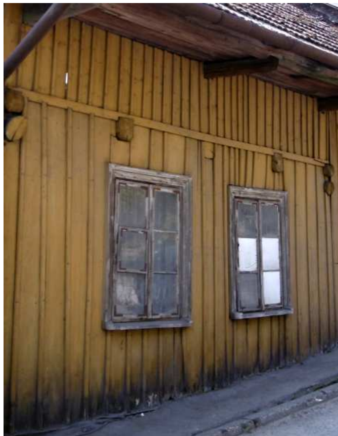
Fot. nr 111. Oryginalne okna domu spod nr 20 (93), otwierane na zewnątrz.
