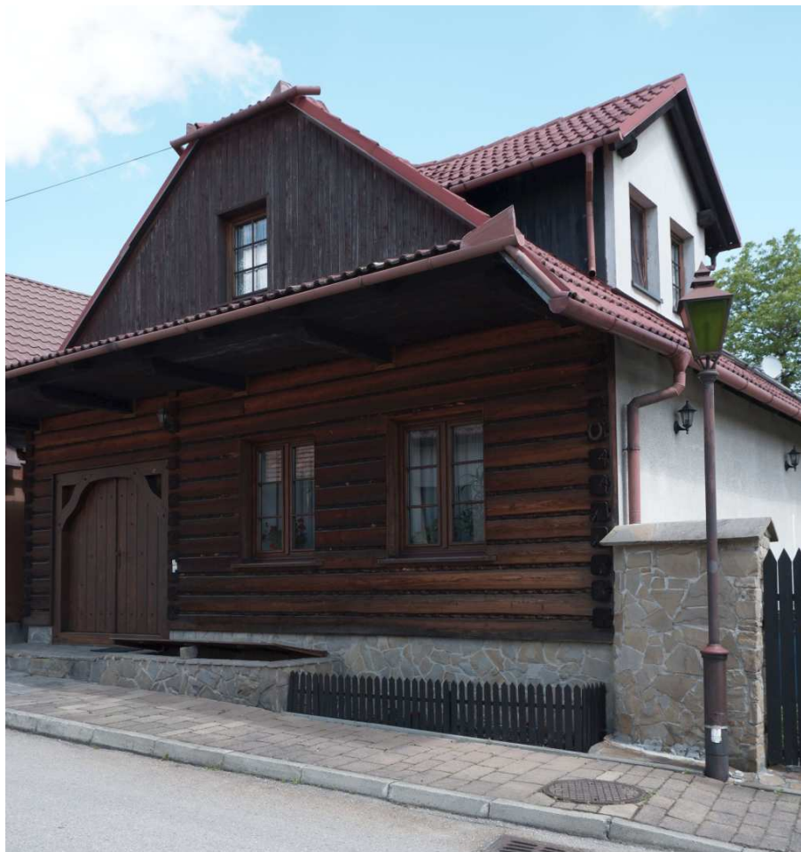
Fot. nr 342. Dom spod nr 17 (pierwotnie nr 183), z datowaniem na rok 1870, w wersji po współczesnej odnowie.
