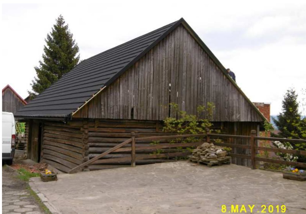
Fot. nr 190 (190-191). Tradycyjna stodoła o konstrukcji zrębowej z ulicy św. Marka, usytuowana blisko jej wylotu do ulicy Podgórskiej, która mogła powstać nawet w ostatniej ćwierci XIX wieku i jej detale.
