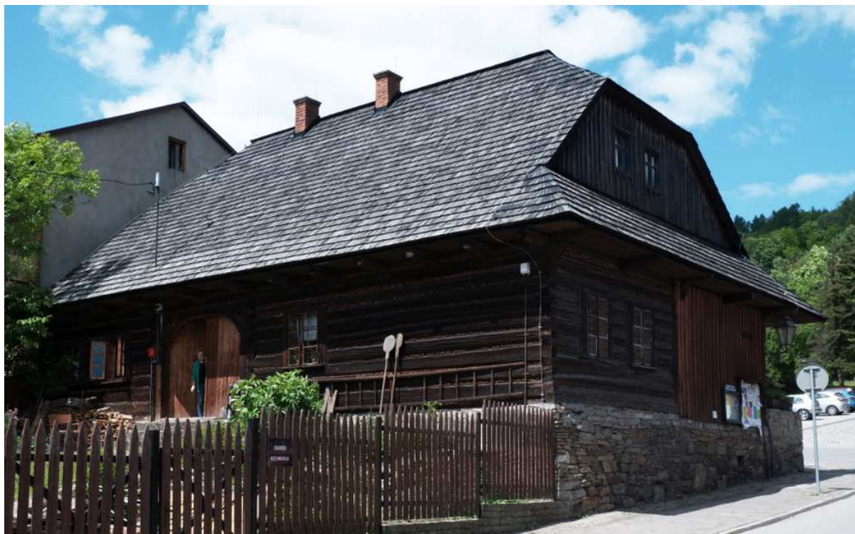
Fot. nr 209. Widok z ulicy Piłsudskiego na tylną jego część.
