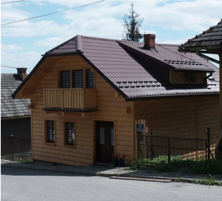
Fot. nr 288. Współcześnie modyfikowany dom o konstrukcji zrębowej spod 58 (pierwotnie nr 72), który jest datowany na początek XX wieku.
