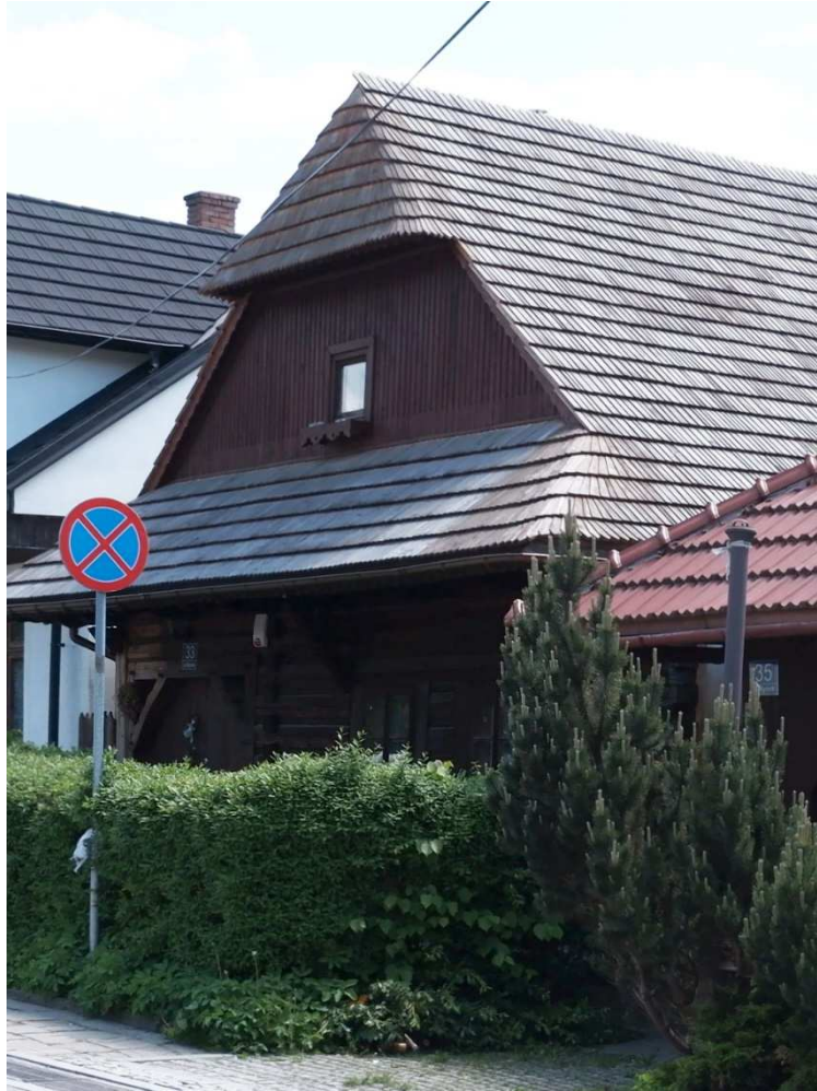
Fot. nr 212. Okapowy dach tego drewniano-murowanego dziś obiektu.
