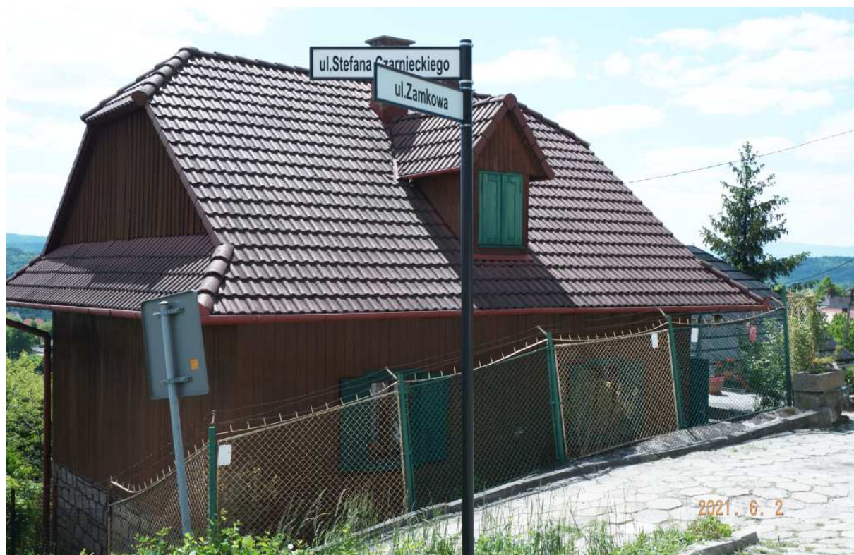
Fot. nr 318. Przebudowany dom o konstrukcji zrębowej z ulicy Zamkowej 12 (pierwotnie nr 33), usytuowany na styku z ulicą Czarnieckiego. Jest datowany na koniec XIX wieku.
