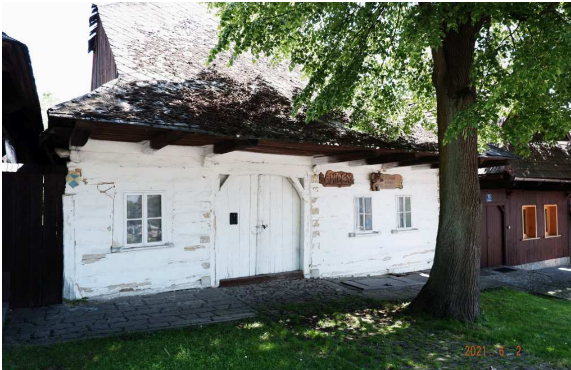
Fot. nr 247 (247-248). Chałupa o konstrukcji zrębowej spod nr 13 (pierwotnie nr 139), również wybudowana w roku 1870, a więc w rok po wielkim pożarze.
