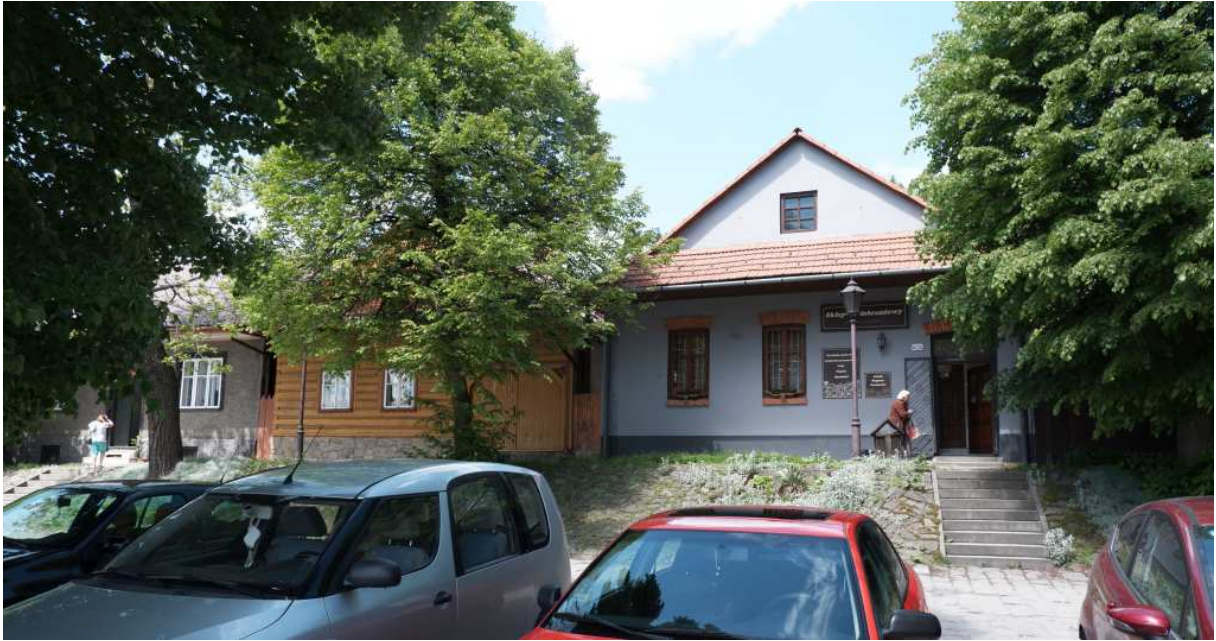
Fot. nr 240. Fragment północnej pierzei o numerach: 59-63. Dom o konstrukcji zrębowej spod nr 63 (pierwszy z prawej) – pierwotnie nr 116, jest datowany na początek XX wieku.
