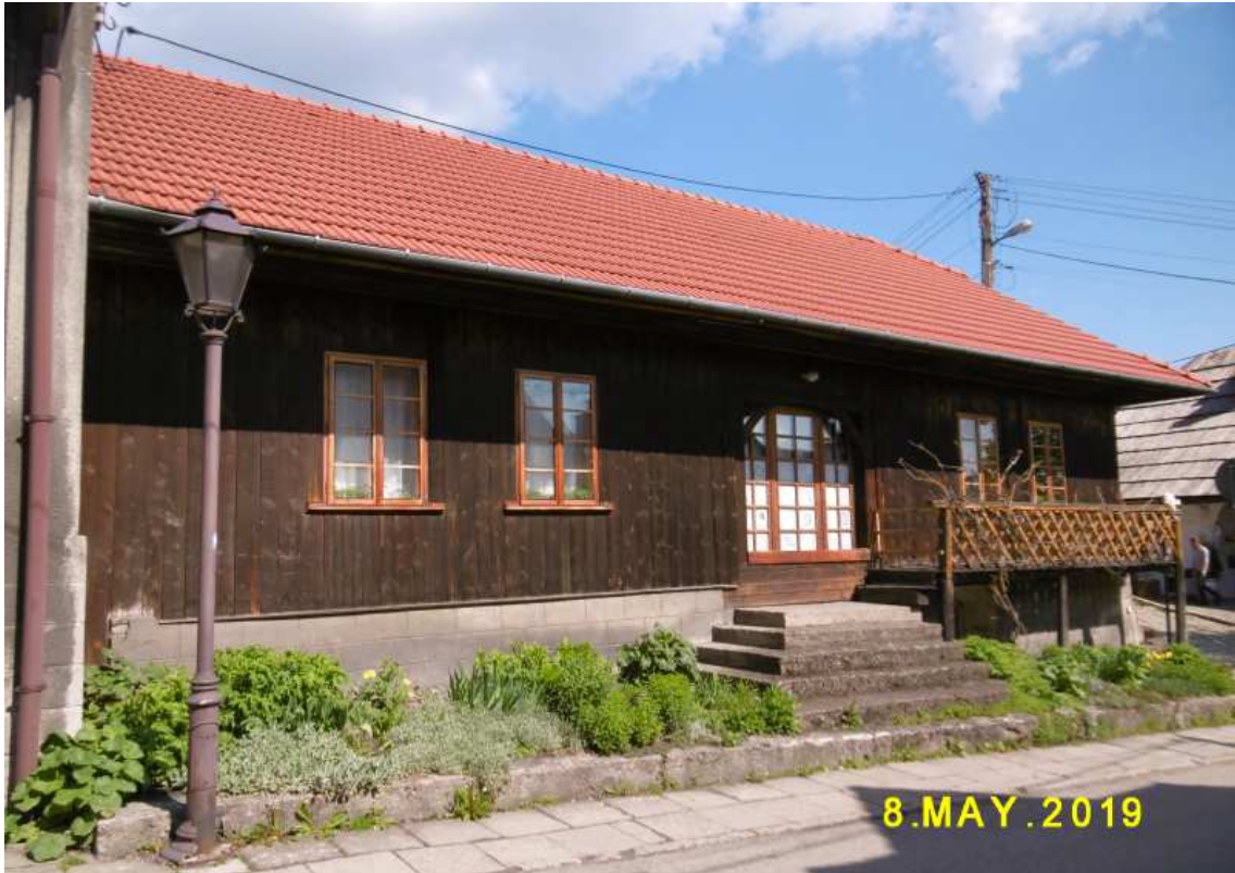
Fot. nr 99 (99-100). Dom spod nr 13 (d. 104) z roku 1870, w narożu z ulicą Zamkową.
