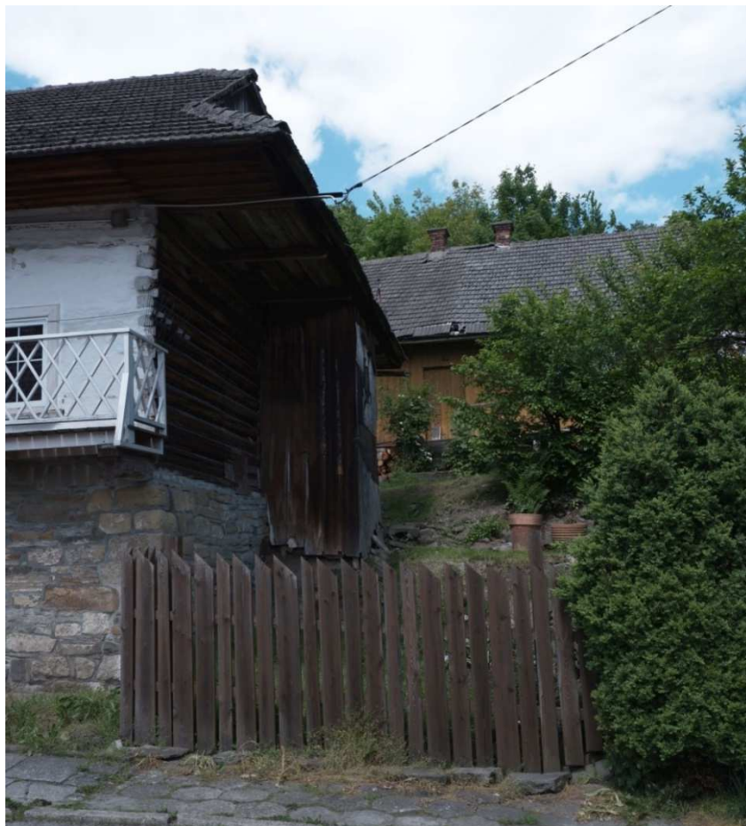
Fot. nr 275 (275-276). Dom o konstrukcji zrębowej spod nr 23 (pierwotnie nr 89), datowany na I połowę XX wieku, raczej przedwojenny, ustytuowany na tyłach domu pod nr 27.
