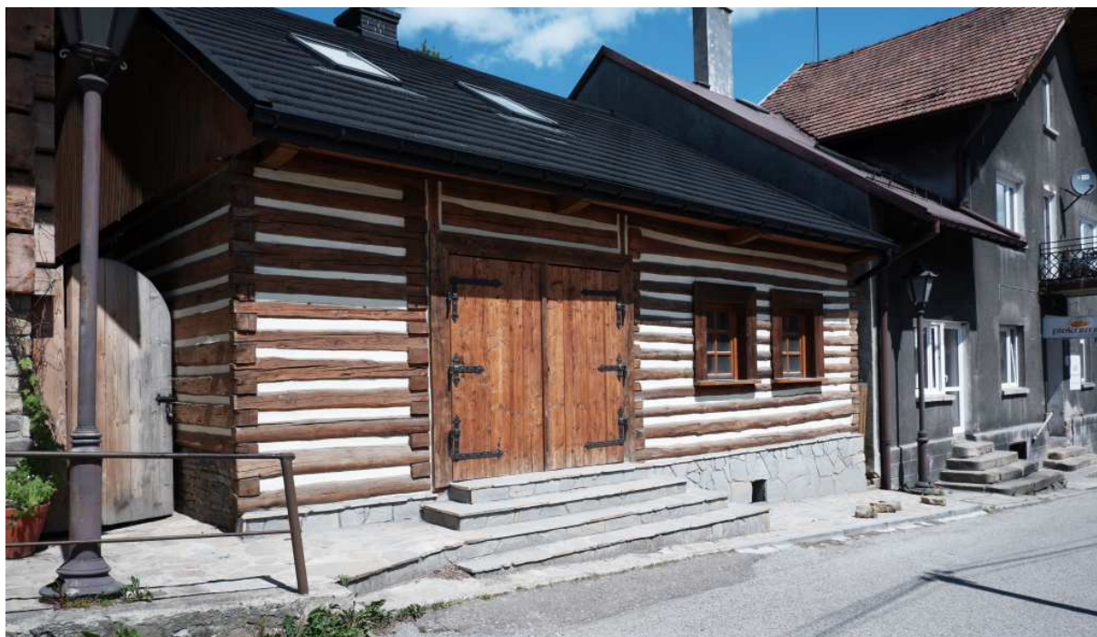
Fot. nr 258. Kolejny współcześnie przebudowany dom o konstrukcji zrębowej spod nr 5 (pierwotnie nr 110), powstały w roku 1870. Obiekt figuruje w rejestrze zabytków, choć oknom daleko do dawnego oryginału.
