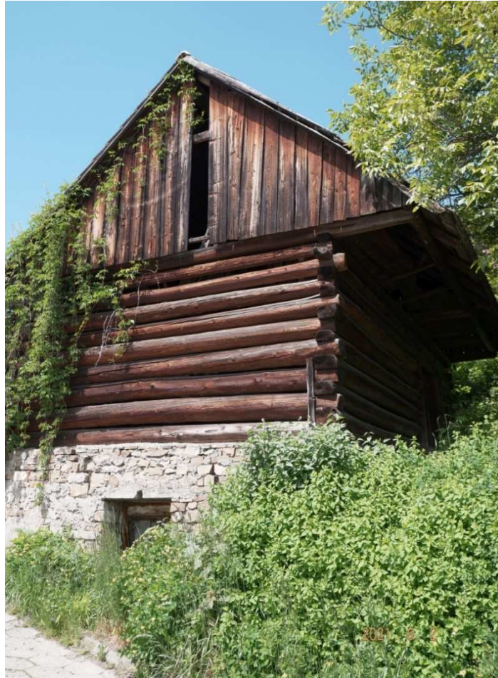
Fot. nr 320. Stodoła o konstrukcji zrębowej na posesji pod nr 2, datowana na I połowę XX wieku (raczej jego I ćwierć).
