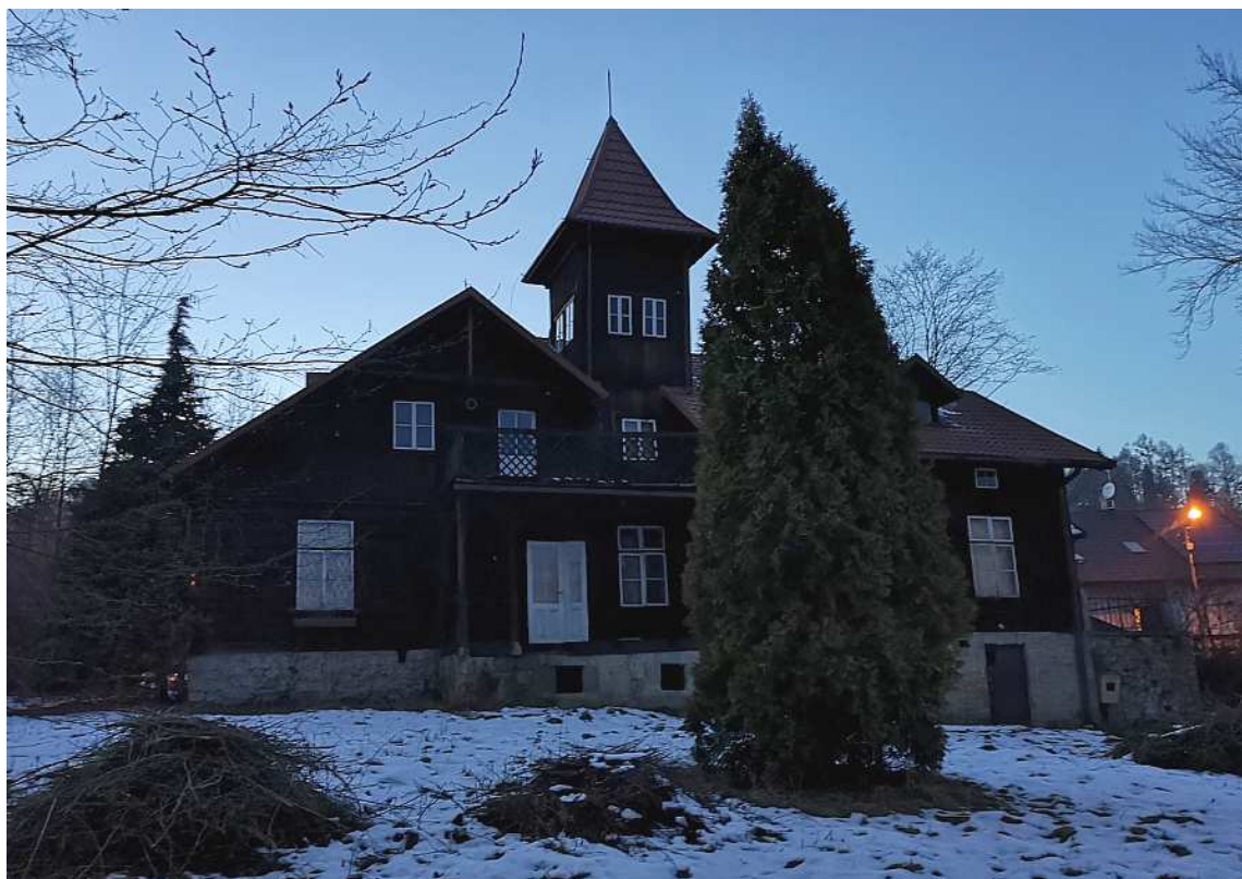
Fot. nr 370c. Widok od strony południowej. (09.02.2020).
