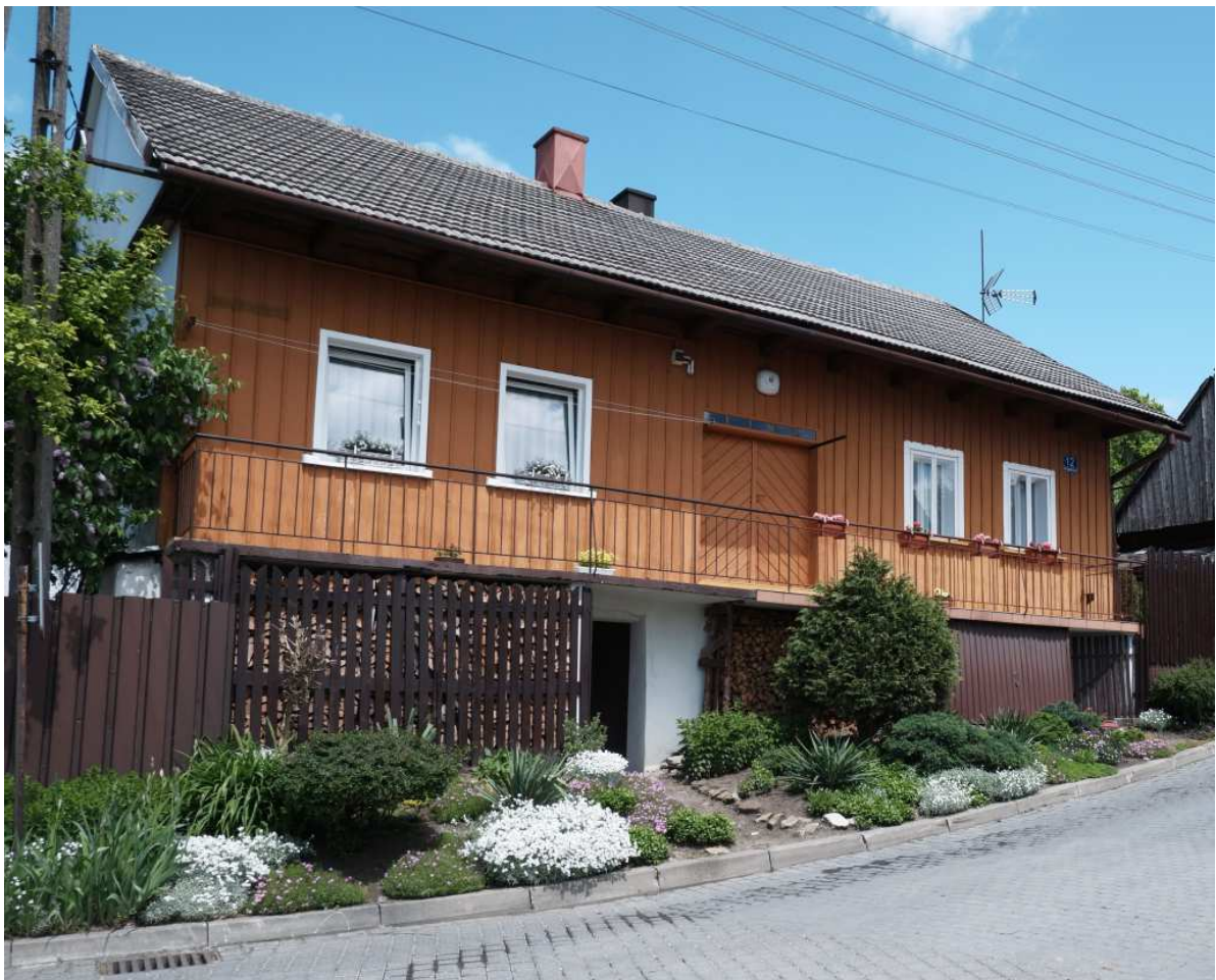
Fot. nr 363. Oszalowany dom z gankiem o konstrukcji zrębowej spod nr 12 (pierwotnie nr 210). Jest datowany na I połowę XX wieku.
