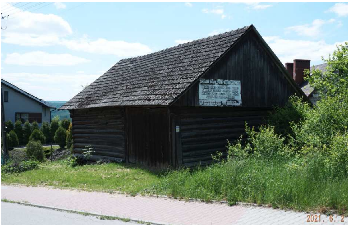
Fot. nr 327 (327-328). Stodoła o konstrukcji zrębowej na posesji pod nr 4 (?), która mogła powstać na początku XX wieku.
