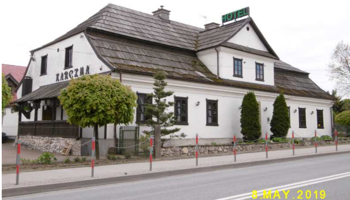
Fot. nr 426 (426-427). Fasada obiektu, w którym zachował się łamany dach.
