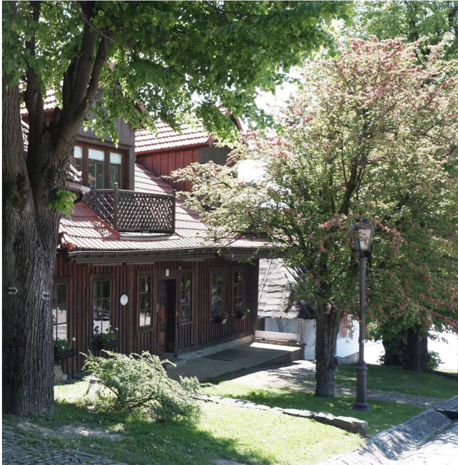
Fot. nr 250. Dom o konstrukcji zrębowej spod nr 17 (pierwotnie nr 141), wg GEZ datowany na I. poł. XX wieku, na którym znać ślady współczesnej przebudowy.
