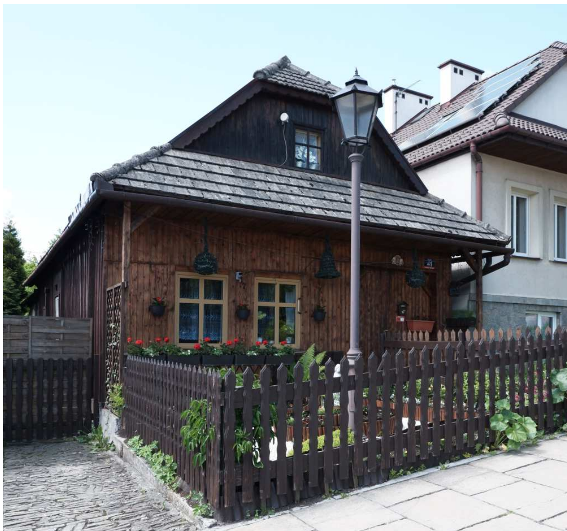
Fot. nr 222. Dom pod nr 41 (pierwotnie 125) to współcześnie odnowiony oryginał o konstrukcji zrębowej, który powstał w roku 1871. Obiekt wpisany do rejestru zabytków.
