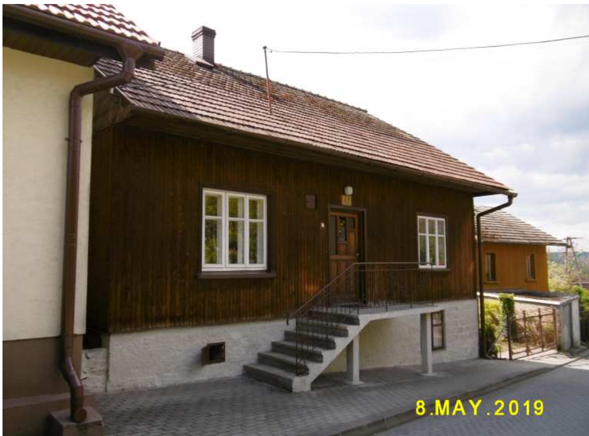
Fot. nr 142. Pokryty boazerią zapewne ponad 100-letni dom spod nr 13 (dawniej 214).
