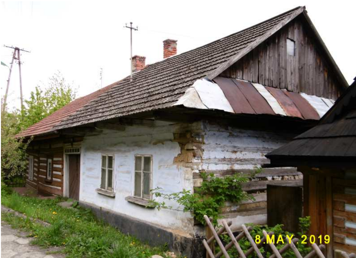
Fot. nr 199 (199-203). Chałupa o konstrukcji zrębowej spod nr 6 (dawniej 27), datowana na I ćwierci XX wieku (raczej jego początek) i jej detale.
