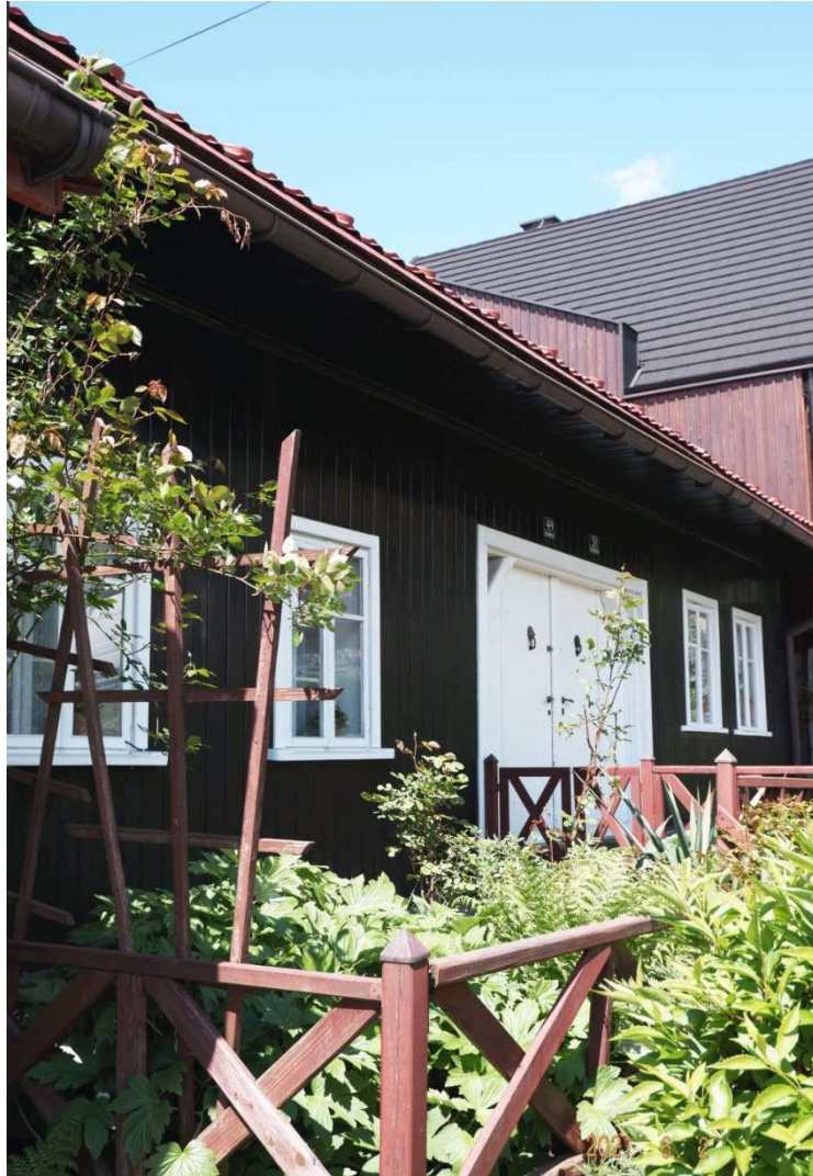
Fot. nr 224. Kompleks dwóch domów o konstrukcji zrębowej spod nr 49-51 (pierwotnie nr 121), datowany na II. połowę XIX wieku.
