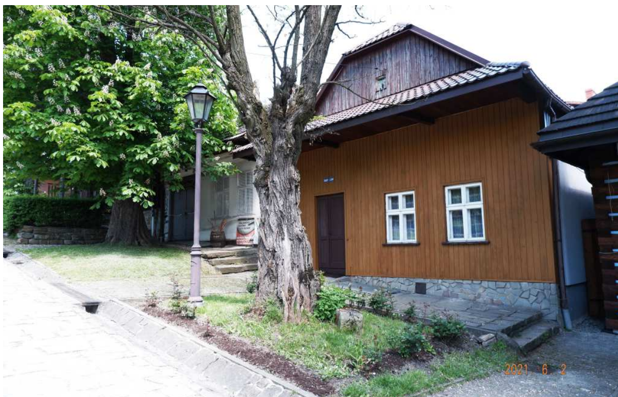
Fot. nr 241. Fragment zabudowy Rynku o numerach: 1-5. Pośrodku remontowany dom o konstrukcji zrębowej spod nr 3 (pierwotnie nr 135), datowany na I połowę XX wieku, raczej jego I. ćwierć.
