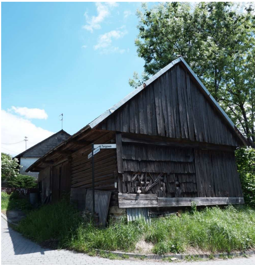
Fot. nr 359. Kolejna stodoła o konstrukcji zrębowej na styku ulic: Targowej i Jagiellońskiej 11, datowana na I połowę XX wieku.
