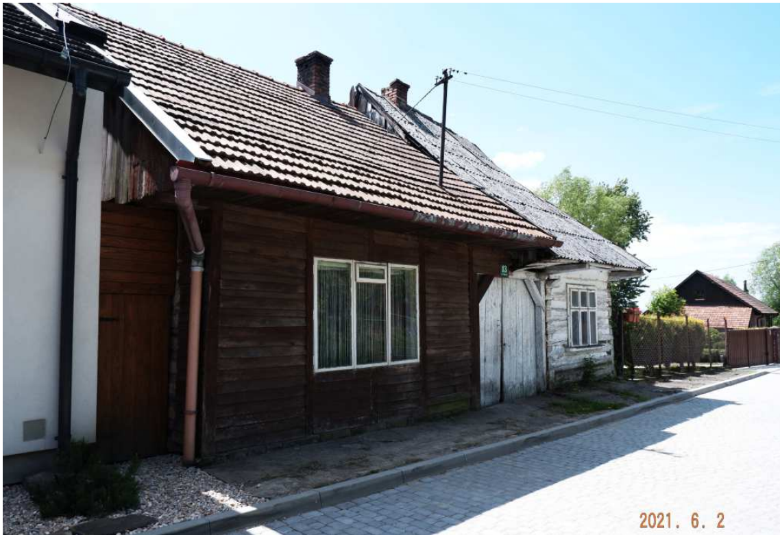
Fot. nr 352 (352-354). Połowicznie przebudowany w roku 1978 dom o konstrukcji zrębowej spod nr 13 (dawniej nr 200).
