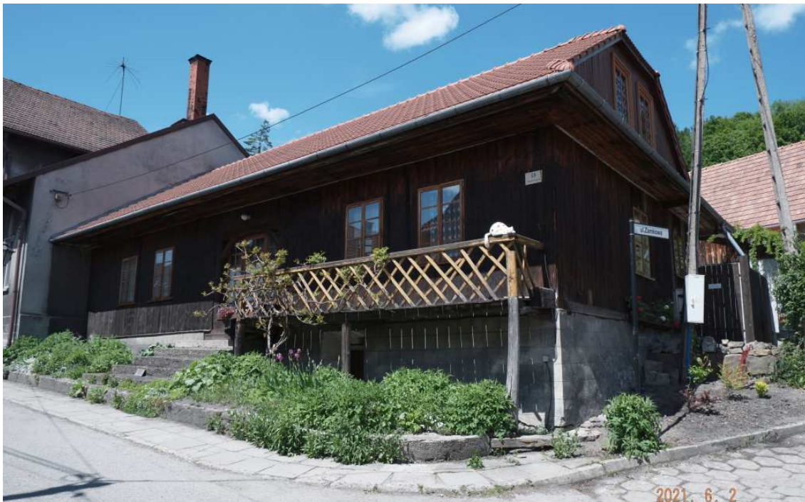
Fot. nr 261. Dom z gankiem o konstrukcji zrębowej spod nr 13 (pierwotnie nr 104), usytuowany w narożu z ulicą Zamkową, wybudowany w roku 1870. Obiekt wpisany do rejestru zabytków.
