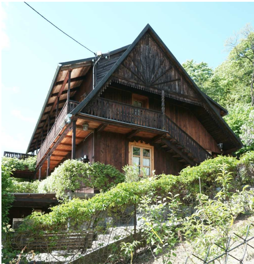
Fot. nr 308. Boczna ściana.
