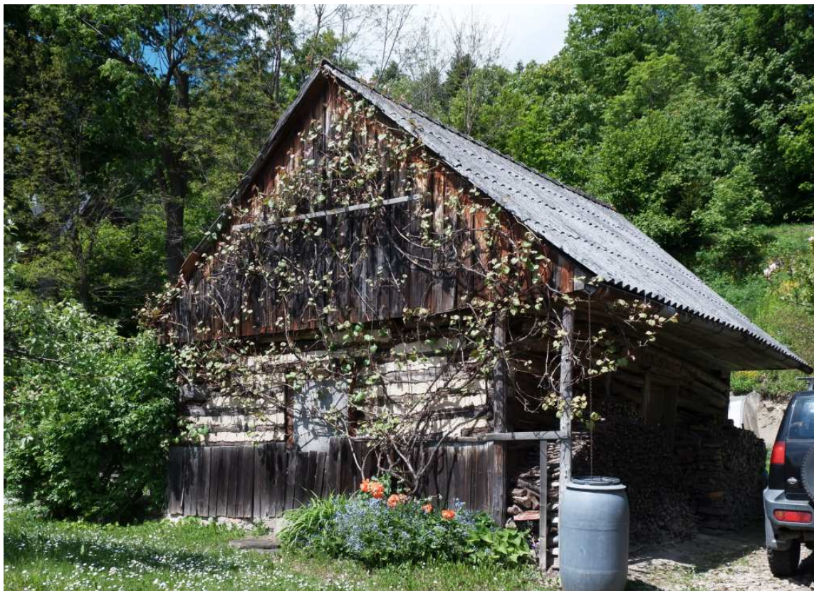
Fot. nr 312. Przylegająca do domu pod nr 17 (zapewne) dawna stodoła o konstrukcji zrębowej.
