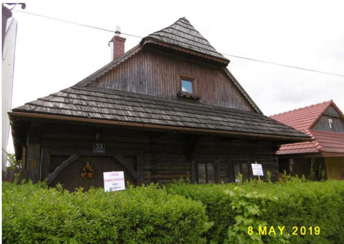
Fot. nr 57 (57-60). Udana replika oryginalnego domu spod nr 33 (128) i jego detale. Został wybudowany w roku 1981, więc nie go w ewidencji zabytków.
