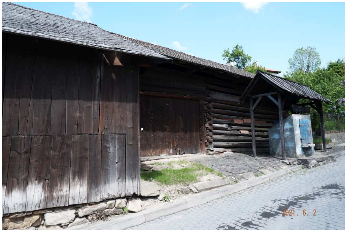
Fot. nr 364 (364-365). Archaiczna stodoła o konstrukcji zrębowej, która najpewniej stoi na posesji pod nr 12. Jej datowanie to II połowa XIX wieku.
