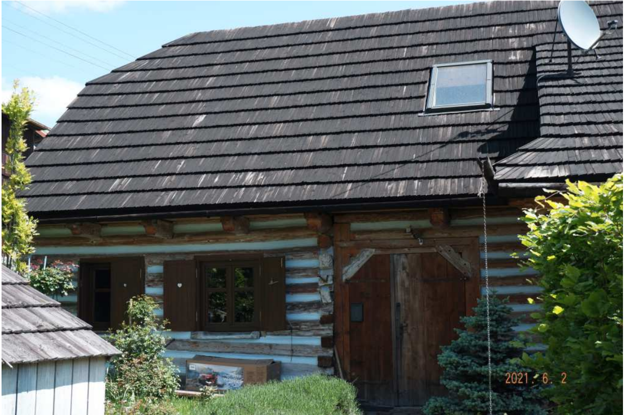
Fot. nr 292. Fasada od strony ulicy.
