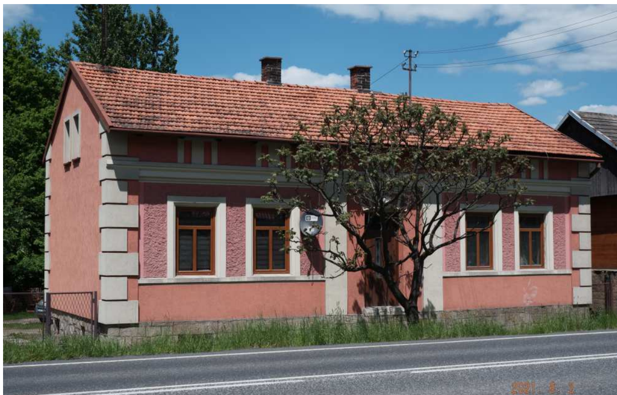
Fot. nr 404 (404-405). Przykładnie odnowiony dom przy ulicy Krakowskiej pod nr 15 murowany, który mógł powstać w latach 30. XX wieku.
