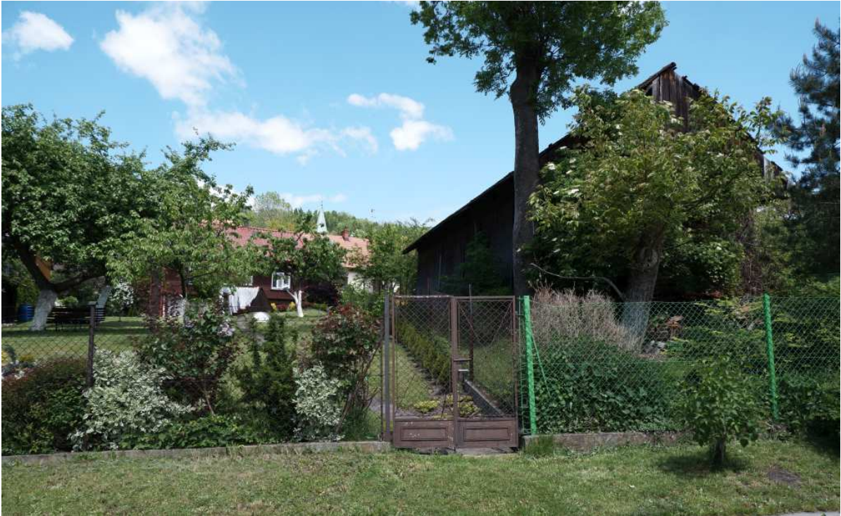
Fot. nr 358. Stodoła wybudowana zapewne w okresie przedwojennym, usytuowana naprzeciw posesji o numerze 25. W tle tyły budynków przy ulicy Jagiellońskiej.
