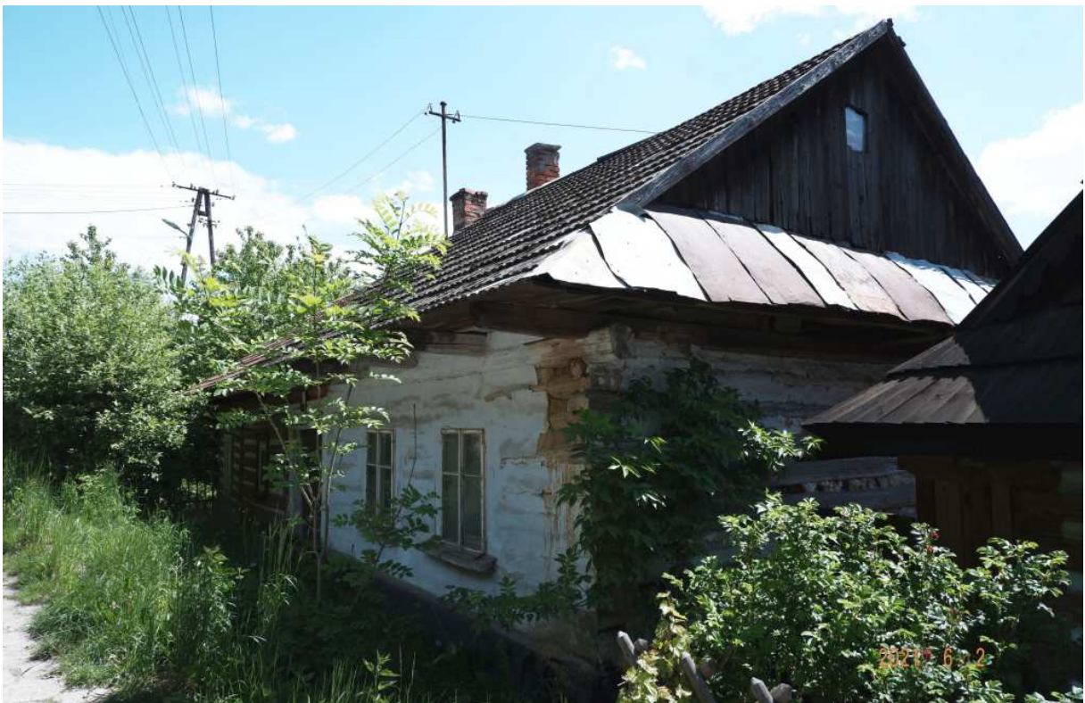
Fot. nr 293 (293-295). Chałupa o konstrukcji zrębowej spod nr 6 (pierwotnie nr 27), wg GEZ wybudowana w I połowie XX wieku, w mojej opinii raczej na samym początku XX wieku.
