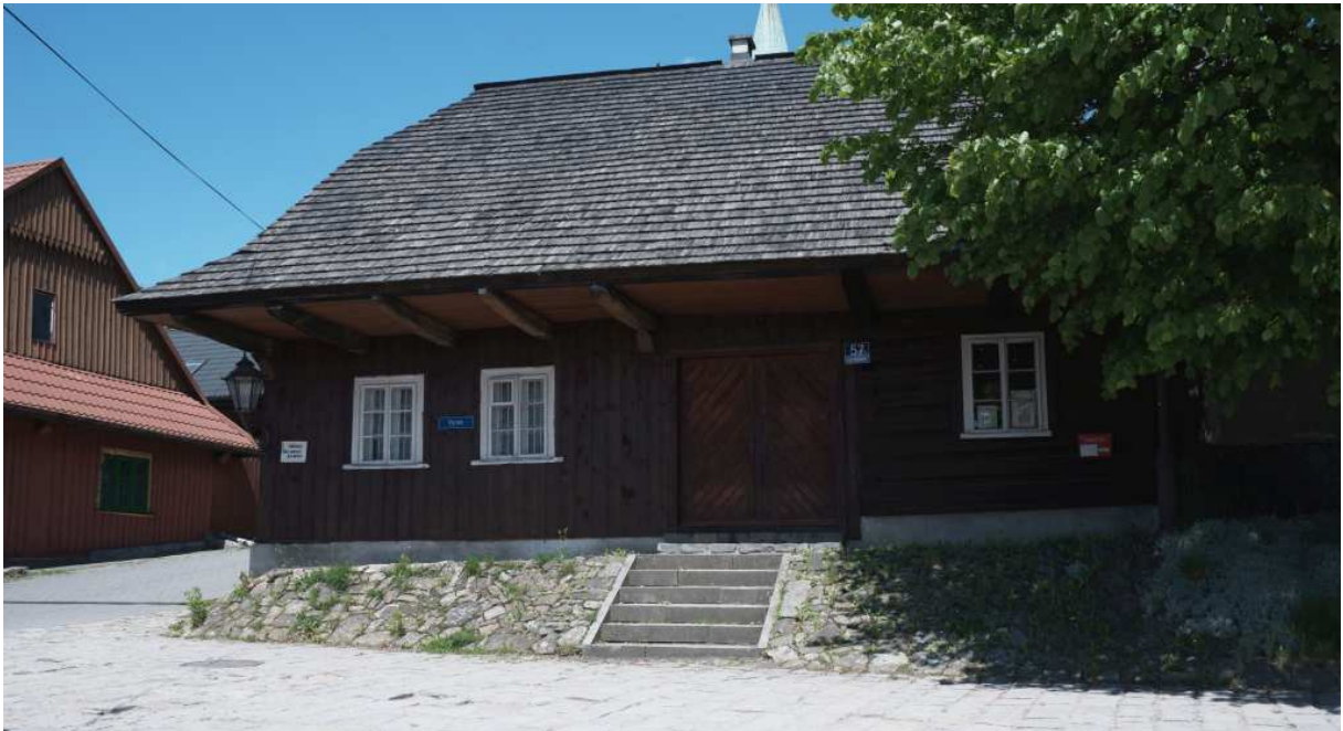
Fot. nr 237. Dom o konstrukcji zrębowej spod nr 57 (pierwotnie nr 119), datowany na II połowę XIX wieku. Obiekt wpisany do rejestru zabytków. W czasach PRL mieściło się w nim Muzeum, potem księgarnia.
