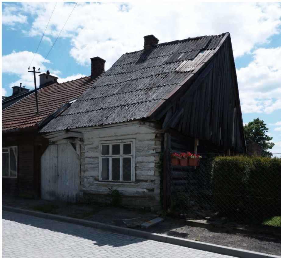
Fot. nr 354. Fragment faktury ścian o konstrukcji zrębowej.
