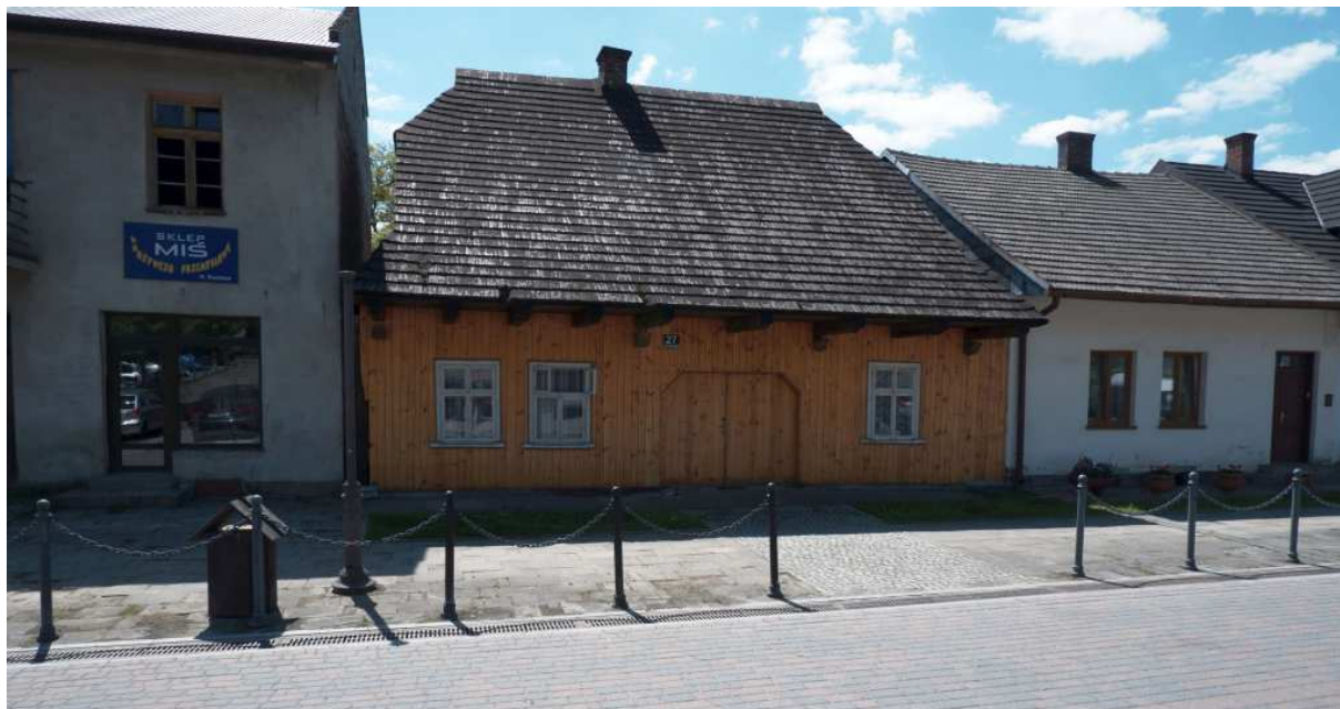
Fot. nr 210. Wpisany do rejestru zabytków, oszalowany dom o konstrukcji zrębowej spod nr 27 (pierwotnie nr 131), datowany na II. poł. XIX wieku.
