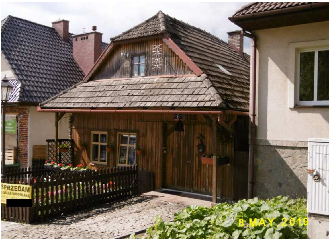
Fot. nr 67. Oszalowany i wpcółczenie odnowiony, zabytkowy dom spod nr 41, powstały zapewne w II połowie XIX wieku, z dachem okapowym podpartym na słupach.
