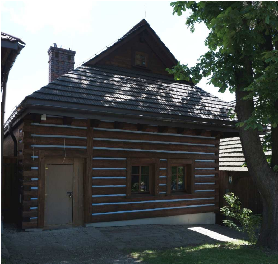
Fot. nr 245. Dom o konstrukcji zrębowej spod nr 7 (pierwotnie nr 136), datowany na II połowę XIX wieku. Drzwi i okna nie są już oryginalne.
