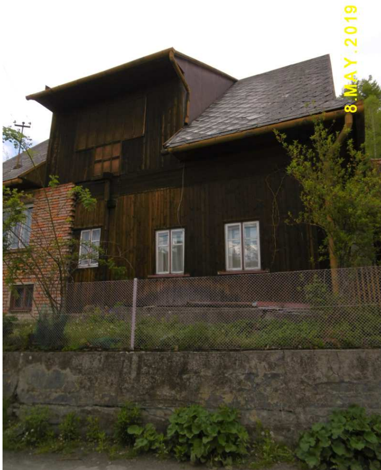
Fot. nr 205. Dom spod nr 3 (d. 28). Nie figuruje w ewidencji zabytków, podobnie jak obiekt spod nr 5. Można przypuszczać, że w oryginale mógł powstać nawet pod koniec XIX wieku
