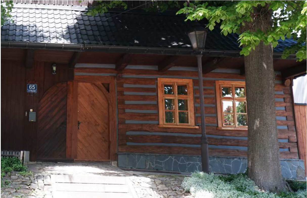
Fot. nr 242. Prawy fragment obiektu z bramą wjazdową pośrodku.
