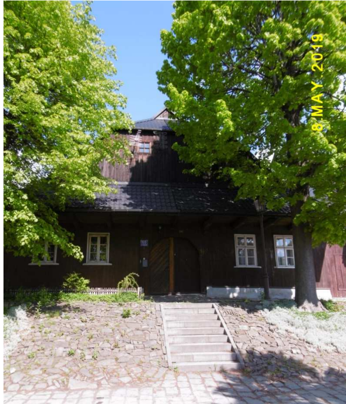
Fot. nr 89 (89-90). Dom spod nr 65 (115), wybudowany w roku 1812.
