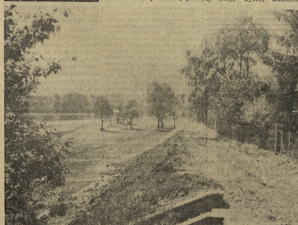
Bulwar spacerowy na lewym brzegu Raby wymagał nawieżenia 5 tys. m sześć. ziemi. KPRD zobowiązało się położyć na nim dywanik asfaltowy tworząc spacerową ścieżkę. Będzie gotowa już w czerwcu.
