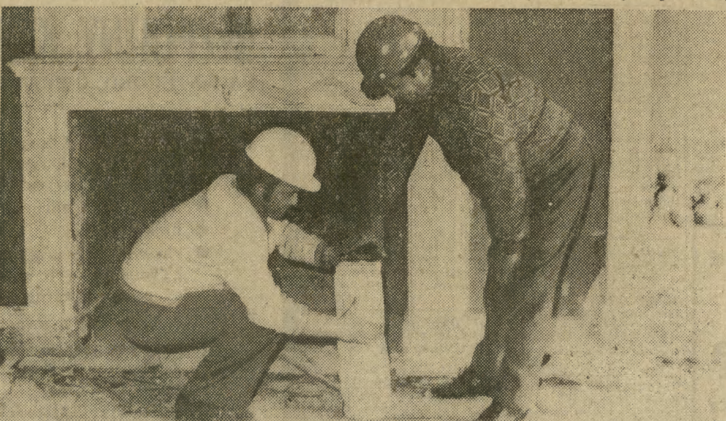
Kierownik wydzielonej grupy robót, Bolesław Rudkowski (w ciemnym helmie) omawia sprawę remontu kominka z kierownikiem działu technicznego Przedsiębiorstwa Rewaloryzacji Zespołów Zabytkowych Krakowa, Zdzisławem Mądrym.
