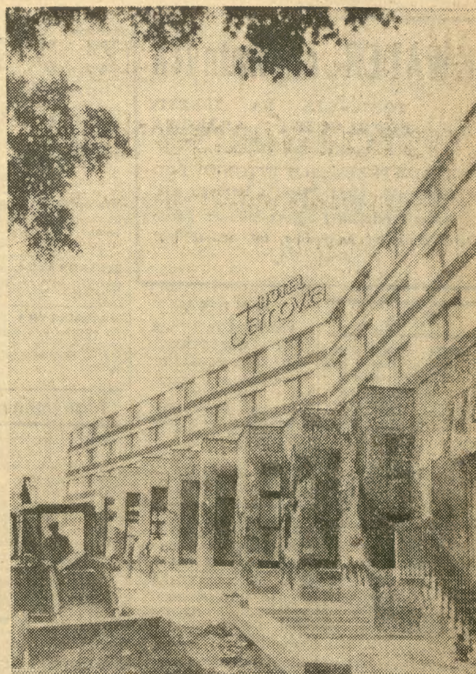
Już wkrótce Tarnów wzbogaci się o nowy hotel usytuowany bardzo dogodnie w pobliżu dworców PKS i PKP, który w dużej mierze rozładuje bardzo trudną sytuację z miejscami noclegowymi w tym mieście. Tarnowskie Przedsiębiorstwo Budownictwa Ogólnego prowadzi obecnie prace wykończeniowe, porządkowe i jeśli nie wyłonią się jakieś nieprzewidziane trudności, jeszcze w tym miesiącu obiekt przejmie Wojewódzkie Przedsiębiorstwo Turystyczne. „Tarnowia” bo taką nazwę będzie nosił ten nowoczesny, o oryginalnej architekturze 4-piętrowy hotel, posiada 104 pokoje jednoosobowe, 68 dwuosobowych i 8 apartamentów oraz bogate zaplecze handlowo-usługowe z restauracją, kawiarnią, kioskiem z pamiątkami, salonem fryzjerskim oraz garażami do dyspozycji gości. Na zdjęciu: prace porządkowe wokół hotelu. Fot. LECH KŁECZEK
