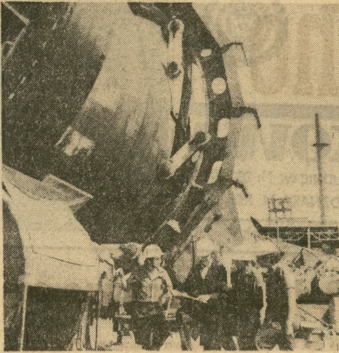
BUDOWA CEMENTOWNI STRZELCE OPOLSKIE
