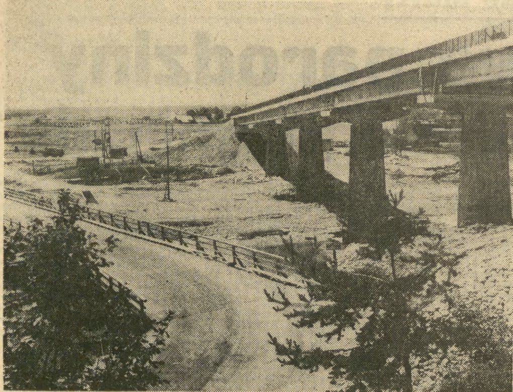
Most nad Dunajcem, jeden z elementów gotowej już drogi, która biegnie wzgórzami otaczającymi przysiółek czorsztynski. W tym rejonie usypany zostanie również wał ziemny, który uchroni Dębno i Frydman od zalania wodami sztucznego jeziora.
